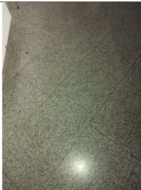
Foto 24 – Piso cozinha (detalhe).
