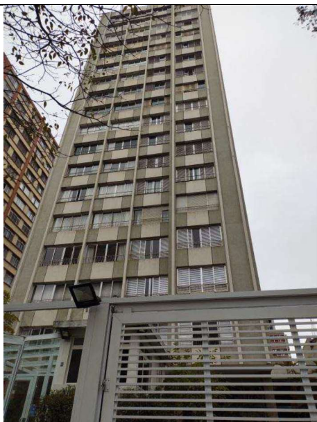
Foto 01 – Vista da fachada principal do Ed. Milus, sito à R. Dr. Fausto Ferraz, 161, Bela Vista/SP/SP.
