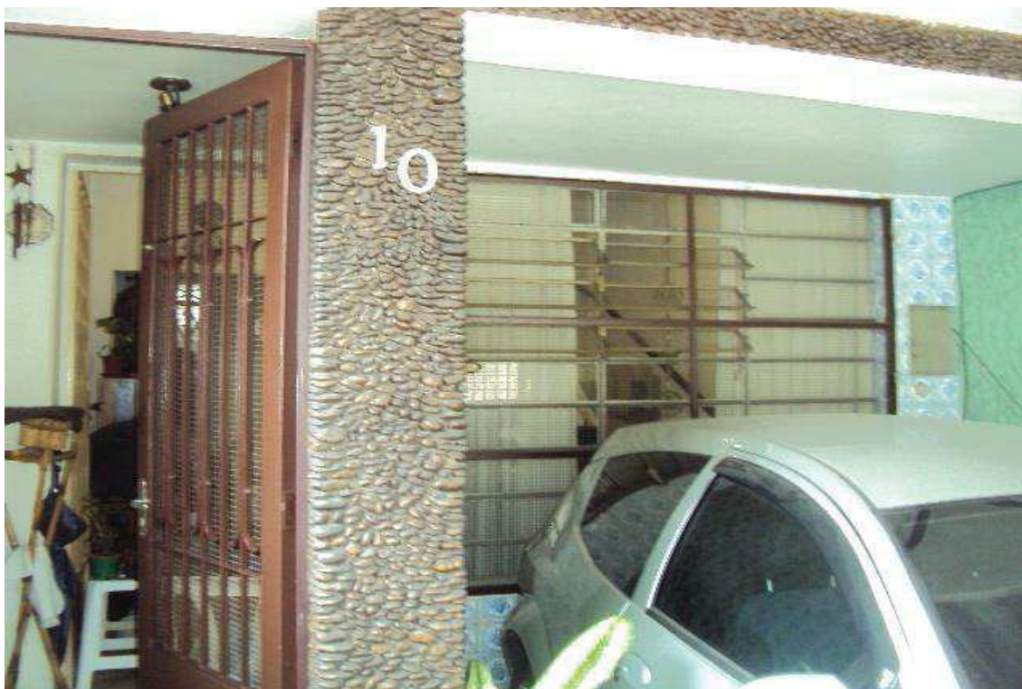
FOTO nº 05 Vista da garagem.
