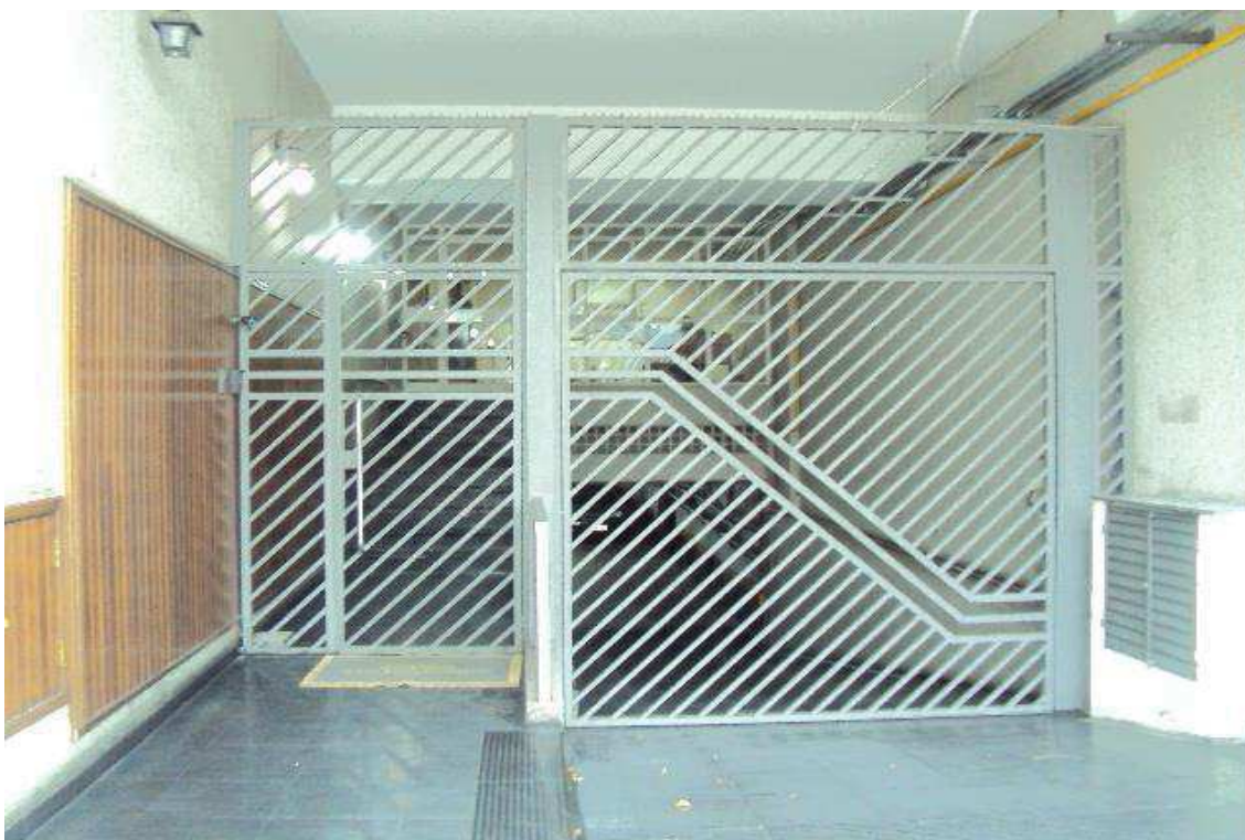
FOTO nº 16 Vista do acesso ao edifício.
