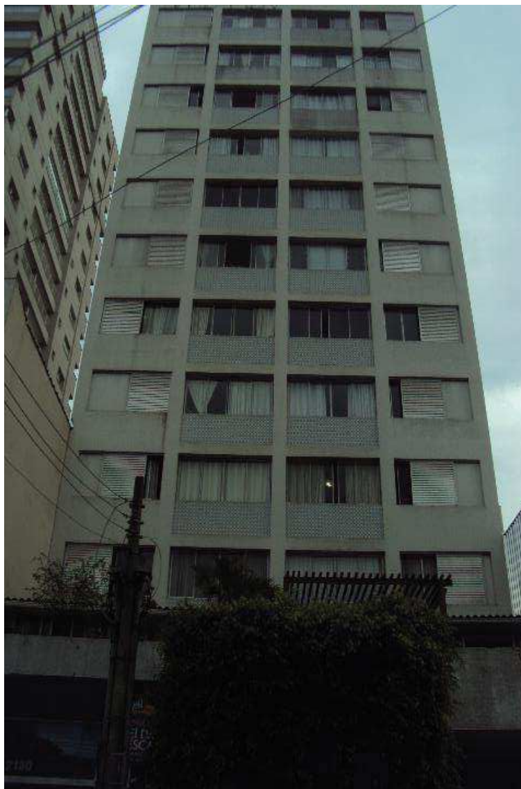
FOTO nº 15 Vista da fachada do edifício.
