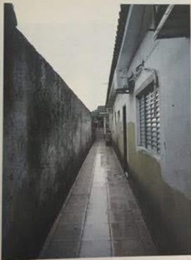
VISTA DO CORREDOR.
