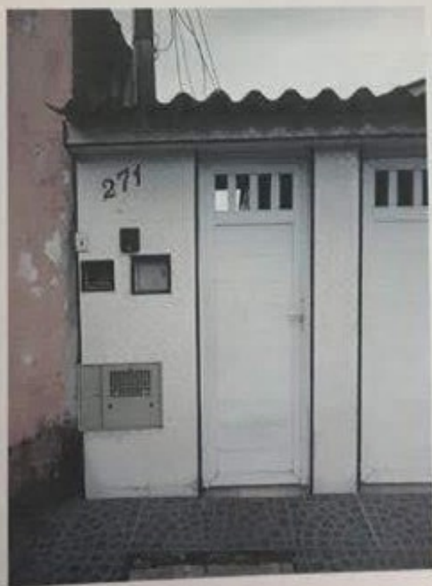
VISTA DA ENTRADA DA CASA 01.
