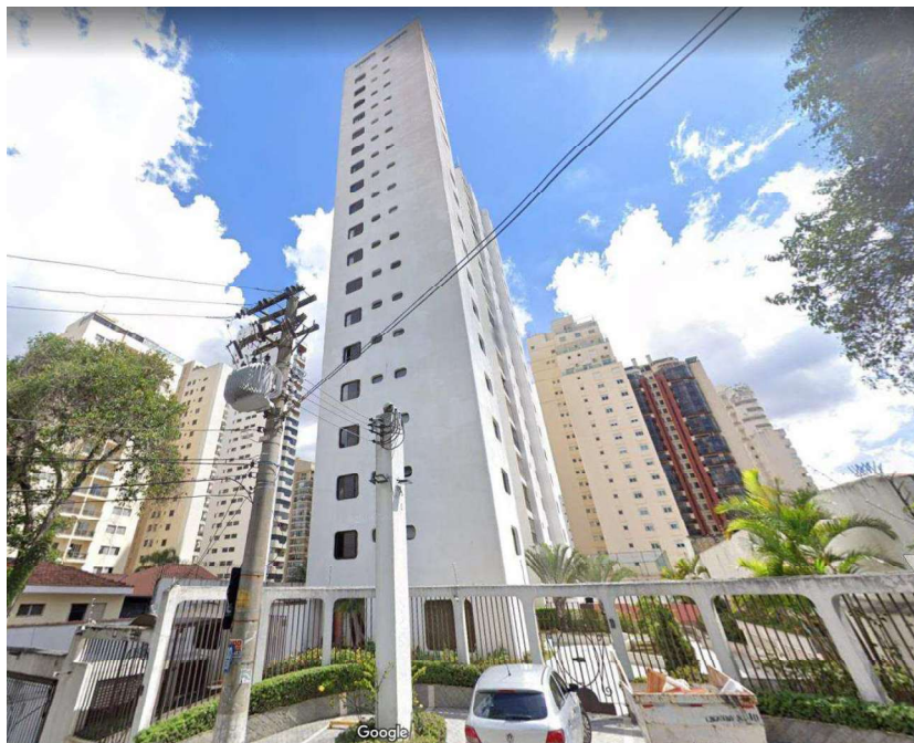
Foto 01 – Frente do edifício, Rua Manoel de Souza nº 35
