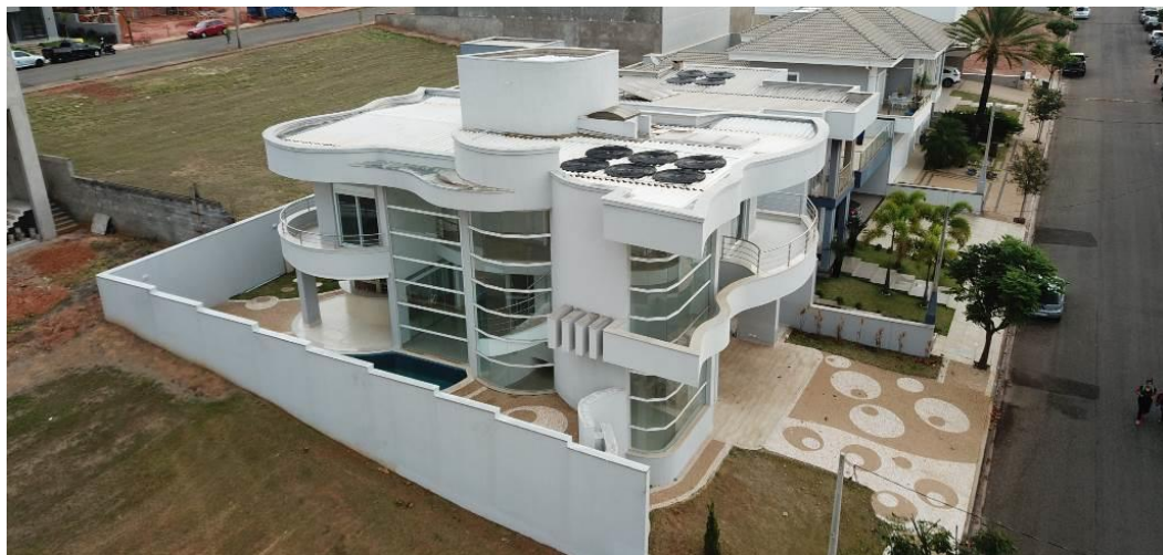
Vista Fachada lateral
