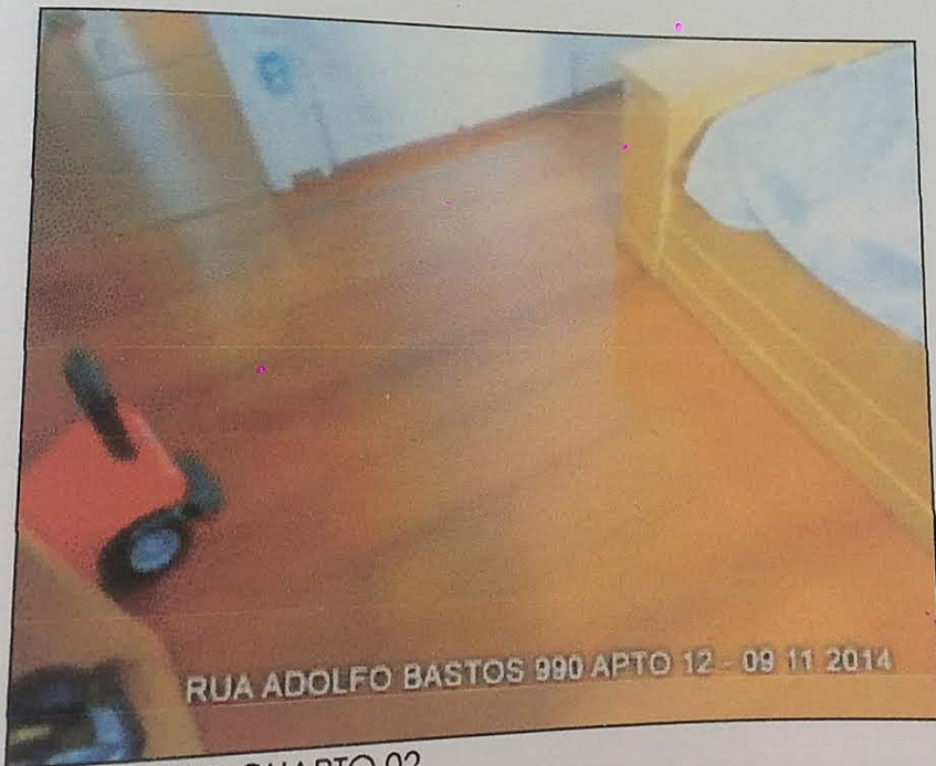
32- PISO DO QUARTO 02
