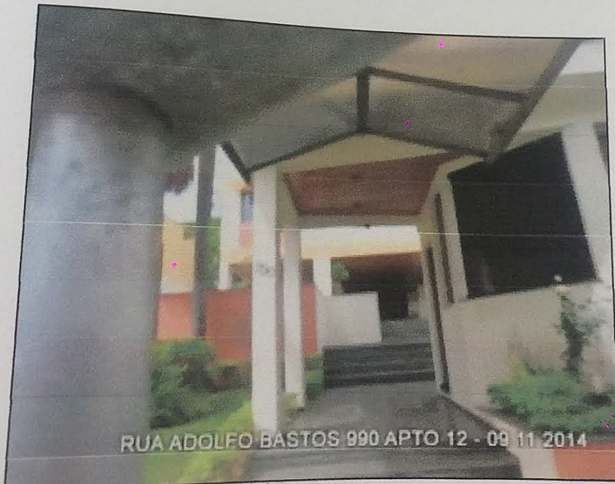
RUA ADOLFO BASTOS 990 APTO 12 - 09 11 2014 06- ENTRANDO NO EDIFÍCIO OBJETO
