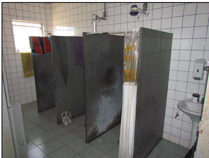
FOTO 11: Vista do vestiário do 1º pavimento.
