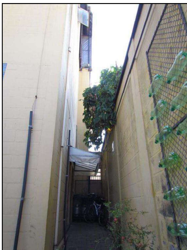
FOTO 03: Vista do corredor externo de acesso ao imóvel avaliando.
