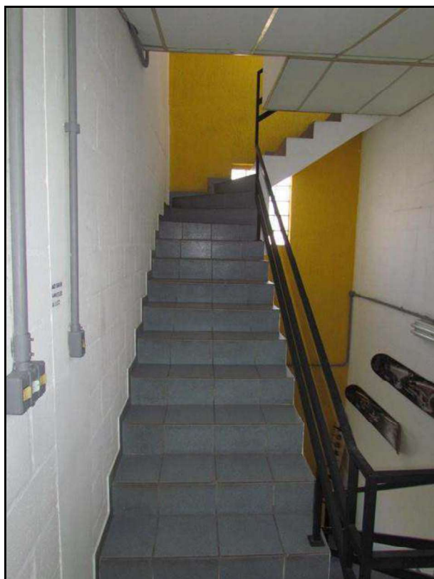
FOTO 13: Vista da escada de acesso ao 2º pavimento.
