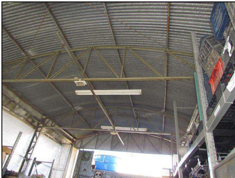
FOTO 20: Outra vista do galpão no 2º pavimento.
