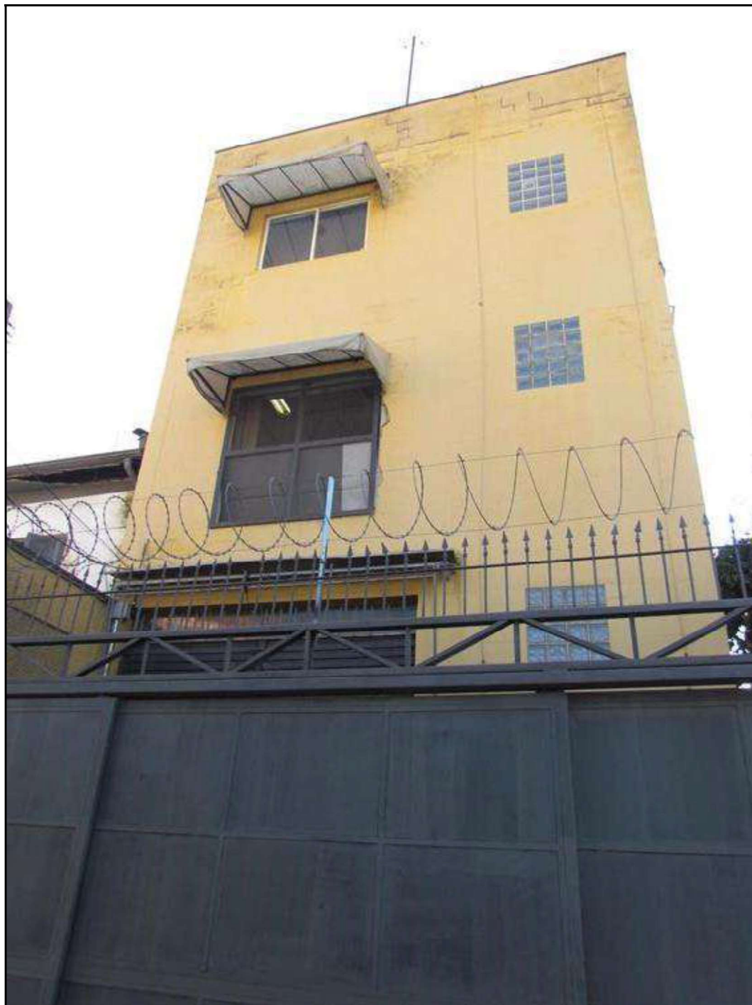
FOTO 01: Vista frontal do imóvel avaliando.
