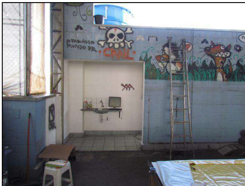
FOTO 18: Vista do hall que antecede o galpão no 2º pavimento.
