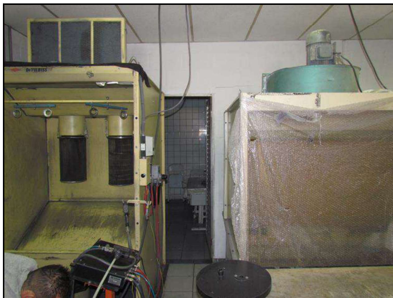
FOTO 10: Outra vista do 1º pavimento.
