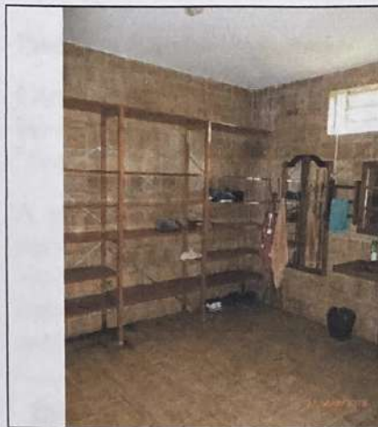
Foto n.º 29. Vista do vestiário 2.
