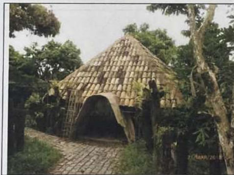
Foto n.º 44. Vista externa da edificação denominada "Flor de Lótus".
