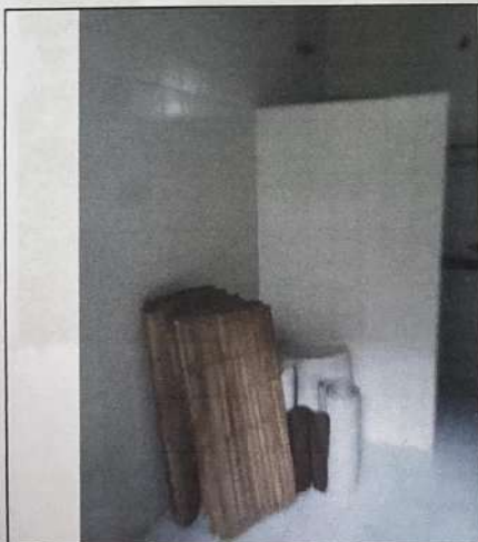
Foto n.º 25. Vista do hall da sauna.
