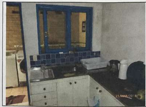
Foto n.º 18. Vista da cozinha/sala de jantar.
