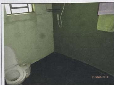
Foto n.º 37. Vista do banheiro 2.
