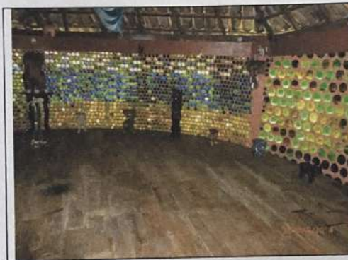
Foto n.º 40. Vista interna da edificação denominada "Templo da Luz".
