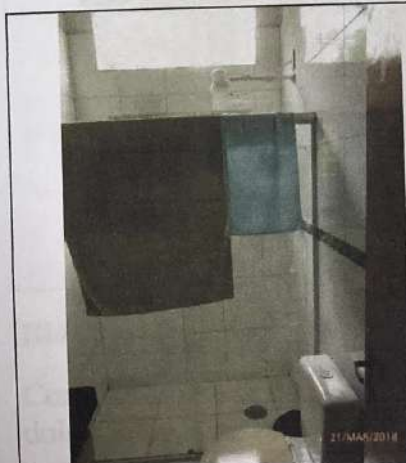
Foto n.º 17. Vista do banheiro do dormitório 2 da suíte.
