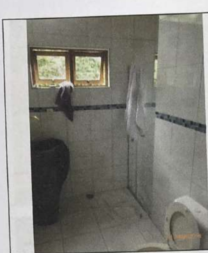
Foto n.º 15. Vista do banheiro do dormitório 1 da suíte.
