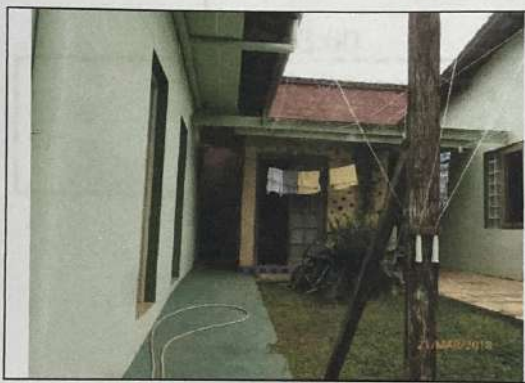
Foto n.º 21. Vista da parte externa do bloco 3.
