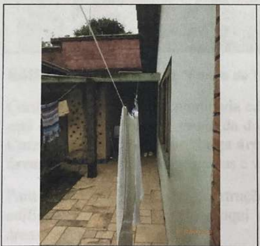
Foto n.º 20. Vista da área de serviço.
