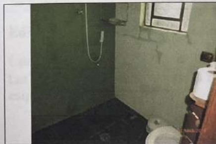
Foto n.º 36. Vista do banheiro 1.
