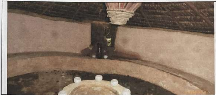
Foto n.º 43. Vista do interior da edificação denominada "Temascal Assasse".
