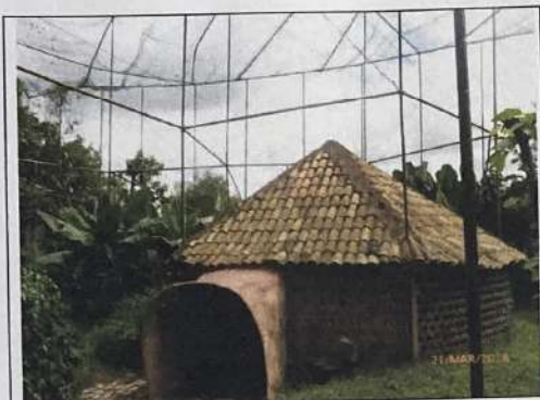
Foto n.º 39. Vista externa da edificação denominada "Templo da Luz".
