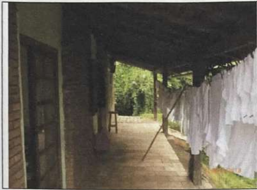
Foto n.º 12. Vista do terraço.
