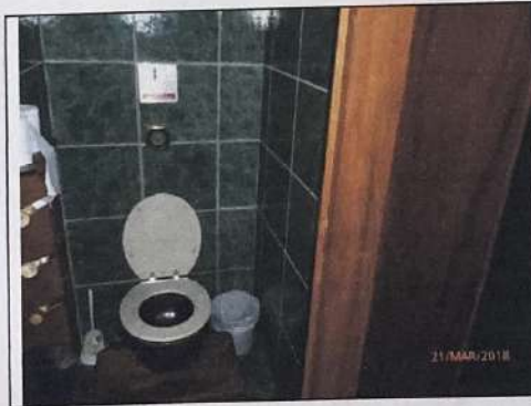
Foto n.º 28. Vista do banheiro do vestiário 1.
