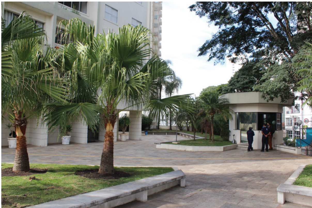
Condomínio Edifício Base das Canoas – Circulação
