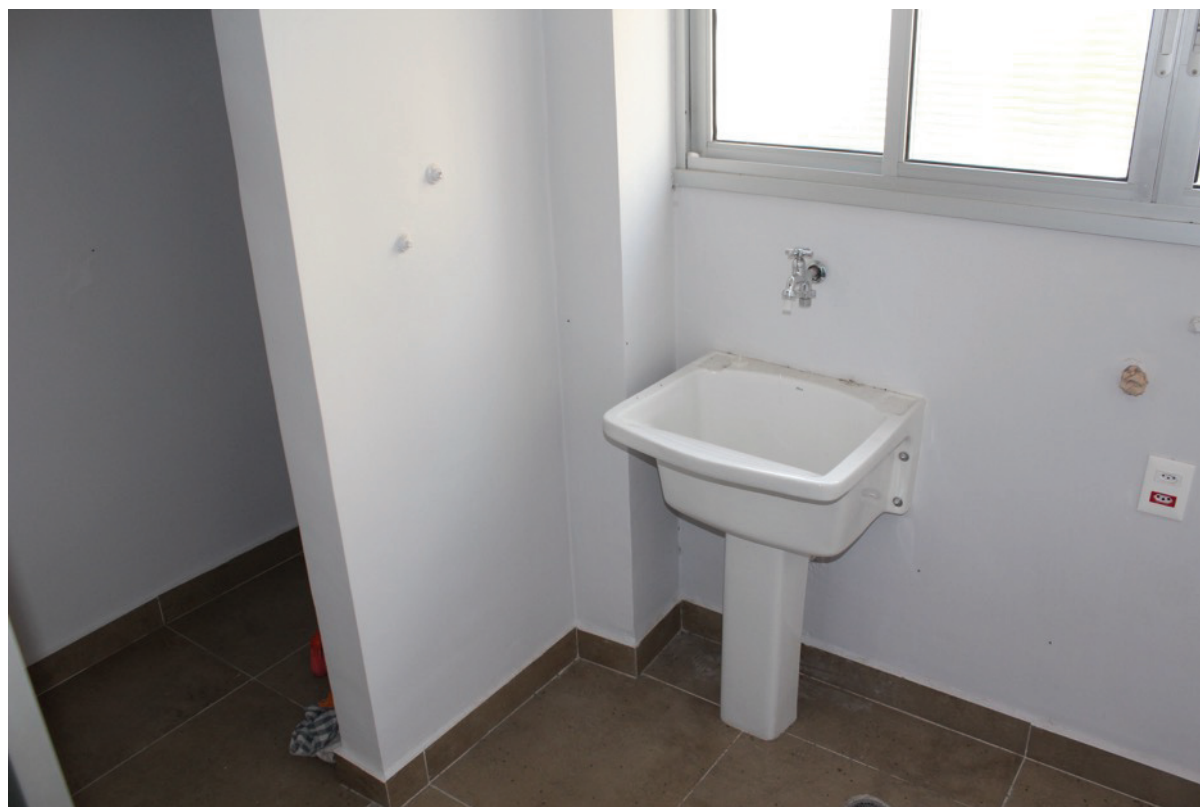
Situação Paradigma – Apartamento Nº 21 – Lavanderia
