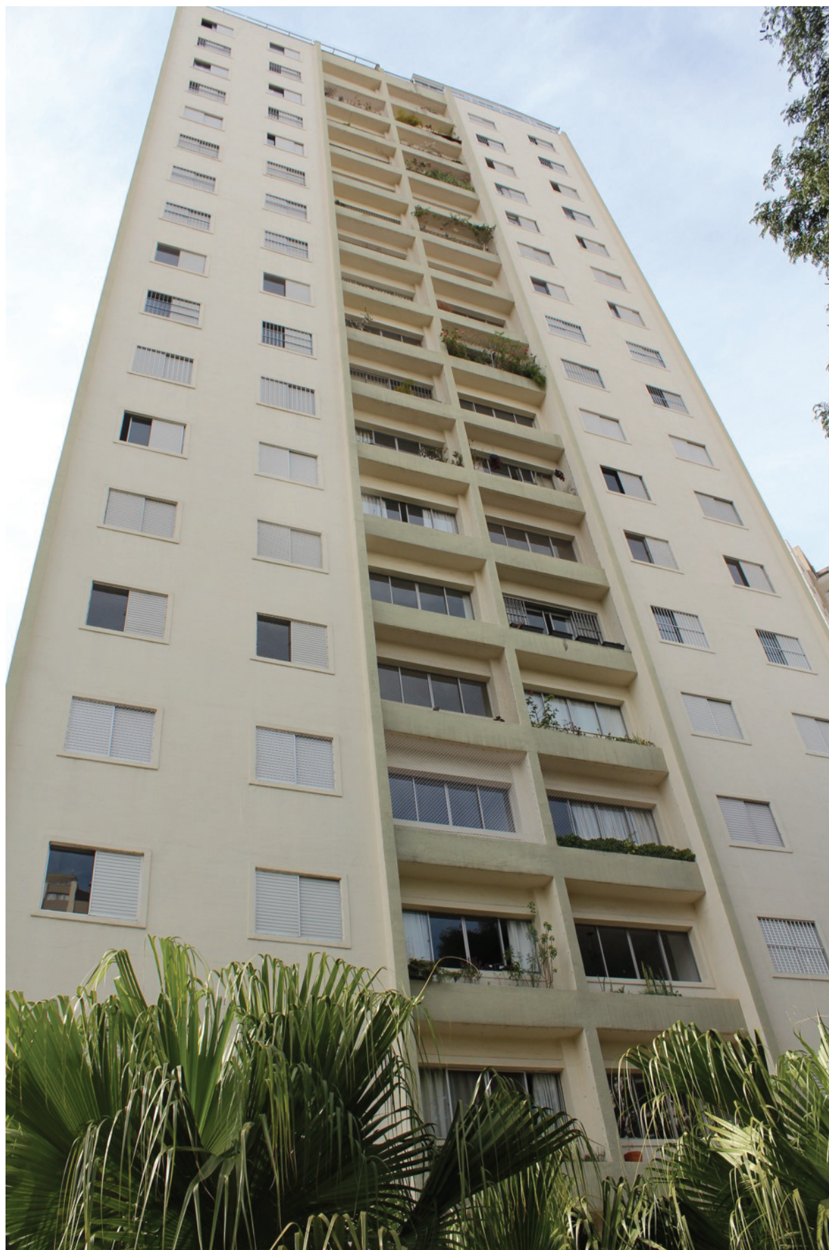
Condomínio Edifício Base das Canoas – Fachada do Edifício
