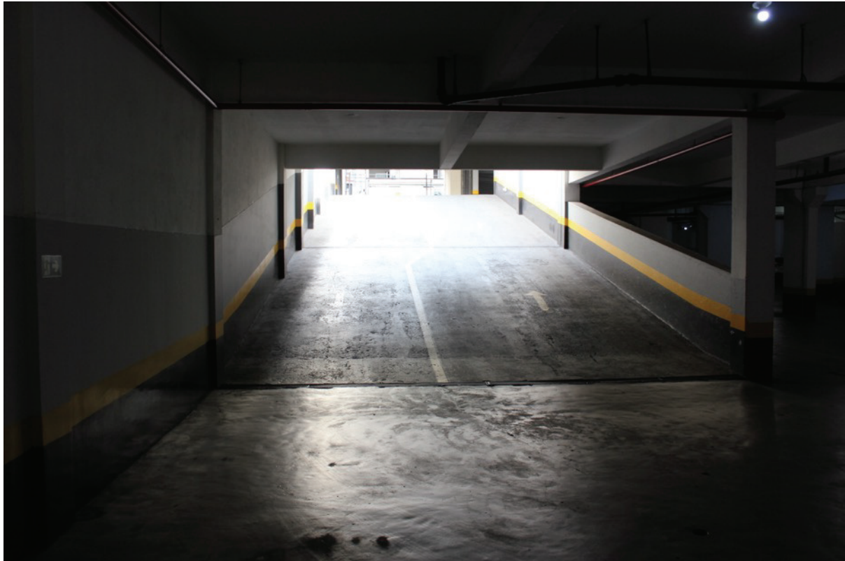
Condomínio Edifício Base das Canoas – Entrada da Garagem Subterrânea
