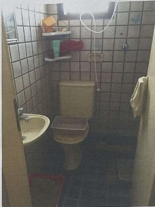
Foto 13 – Banheiro de empregada
