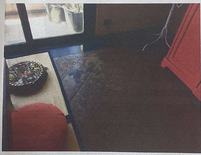
Foto 04 – Piso em madeira
