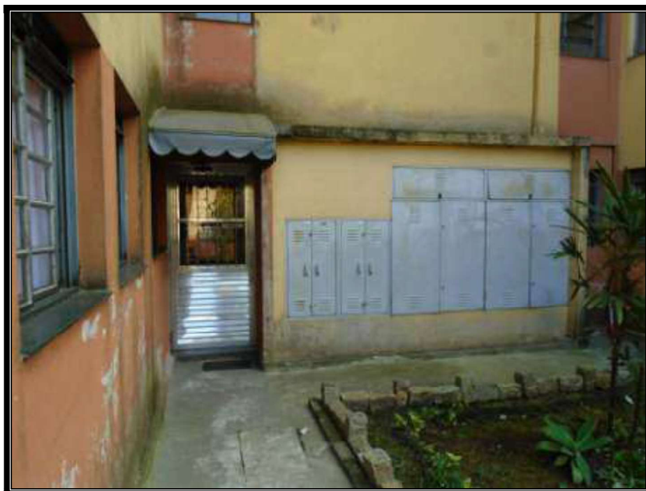
Vista parcial da entrada do edifício.
