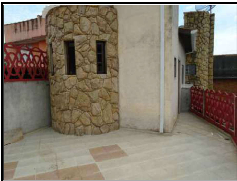
Vista parcial do terraço.
