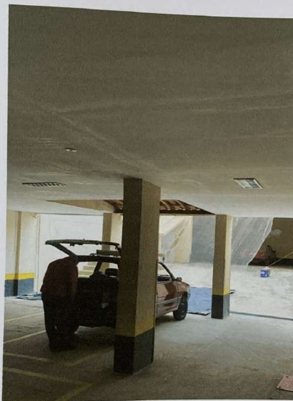
Foto nº. 6 – Vista parcial da garagem localizada no pavimento térreo.
