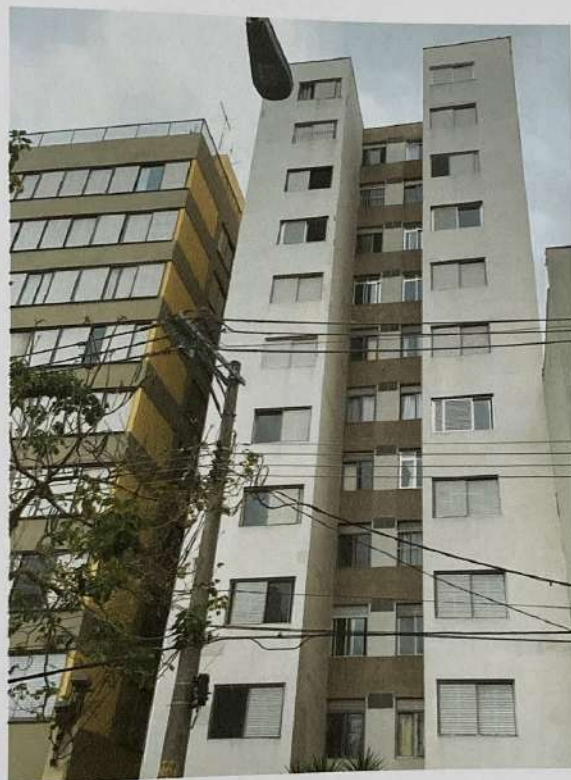
Foto nº. 3 – Vista da fachada frontal do Condomínio Edifício Brigadeiro Galvão, onde se localiza o imóvel avaliado no presente laudo.
