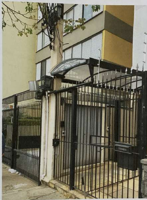
Foto nº. 4 – Vista da entrada de pedestres.
