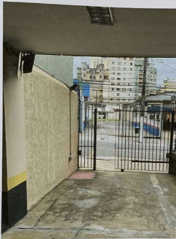
Foto nº. 5 – Vista do acesso de veículos.
