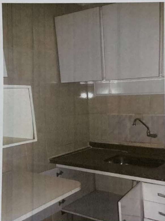
Foto nº. 16 – Vista da cozinha.
