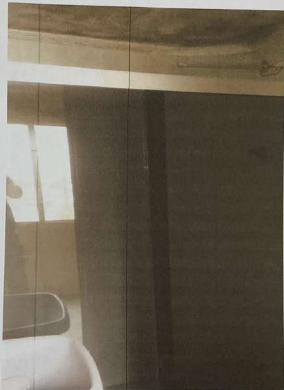
Foto nº. 15 – Vista do banheiro.
