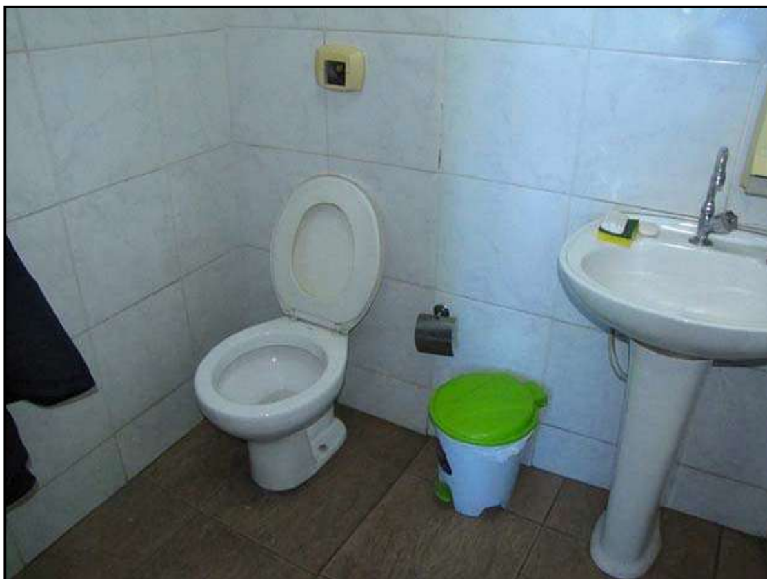
Pavimento superior – sanitário 3
