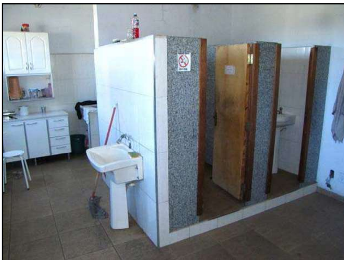
Pavimento superior – vista geral sanitários e copa
