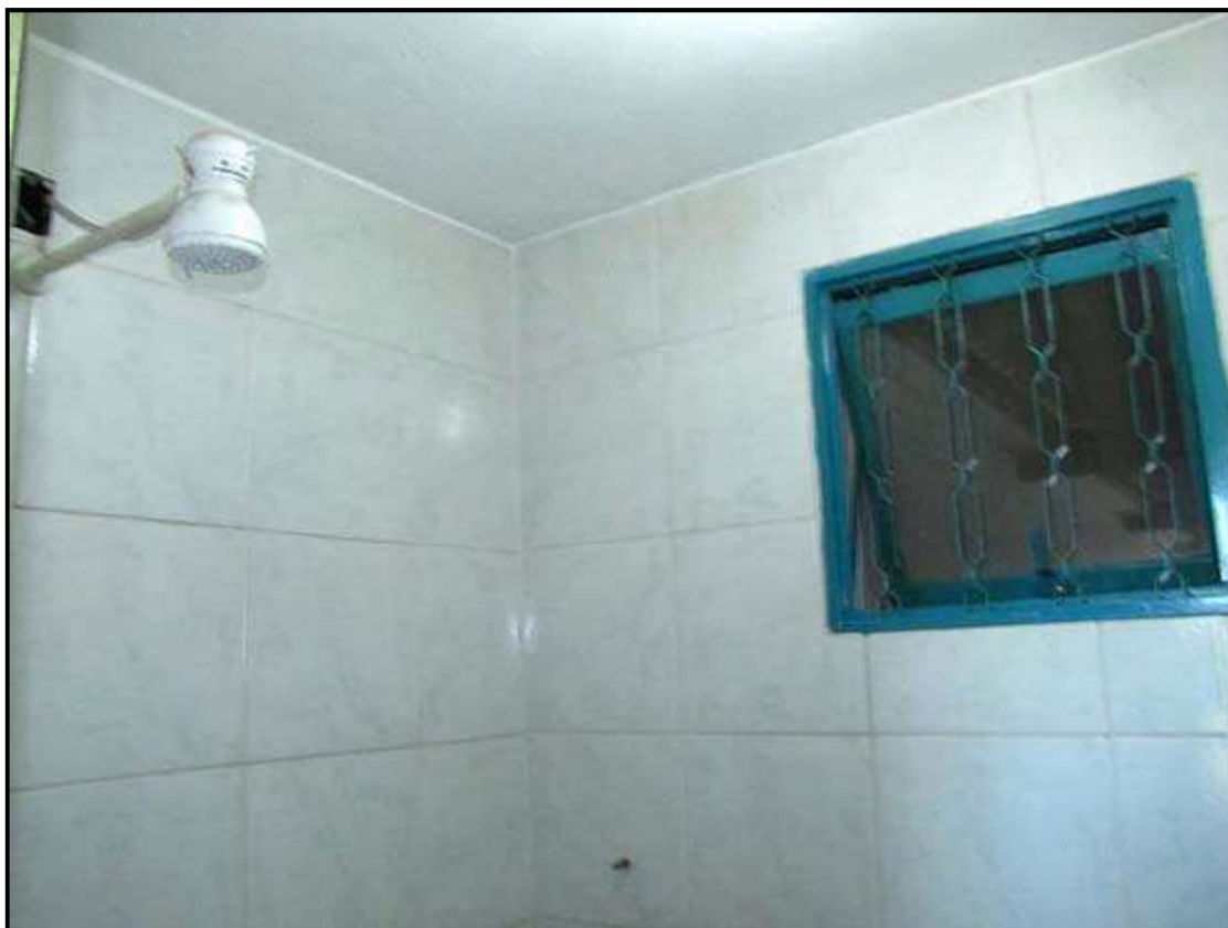
Pavimento superior – sanitário 3
