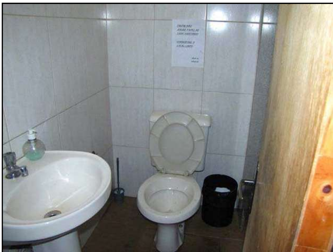
Pavimento superior – sanitário 2
