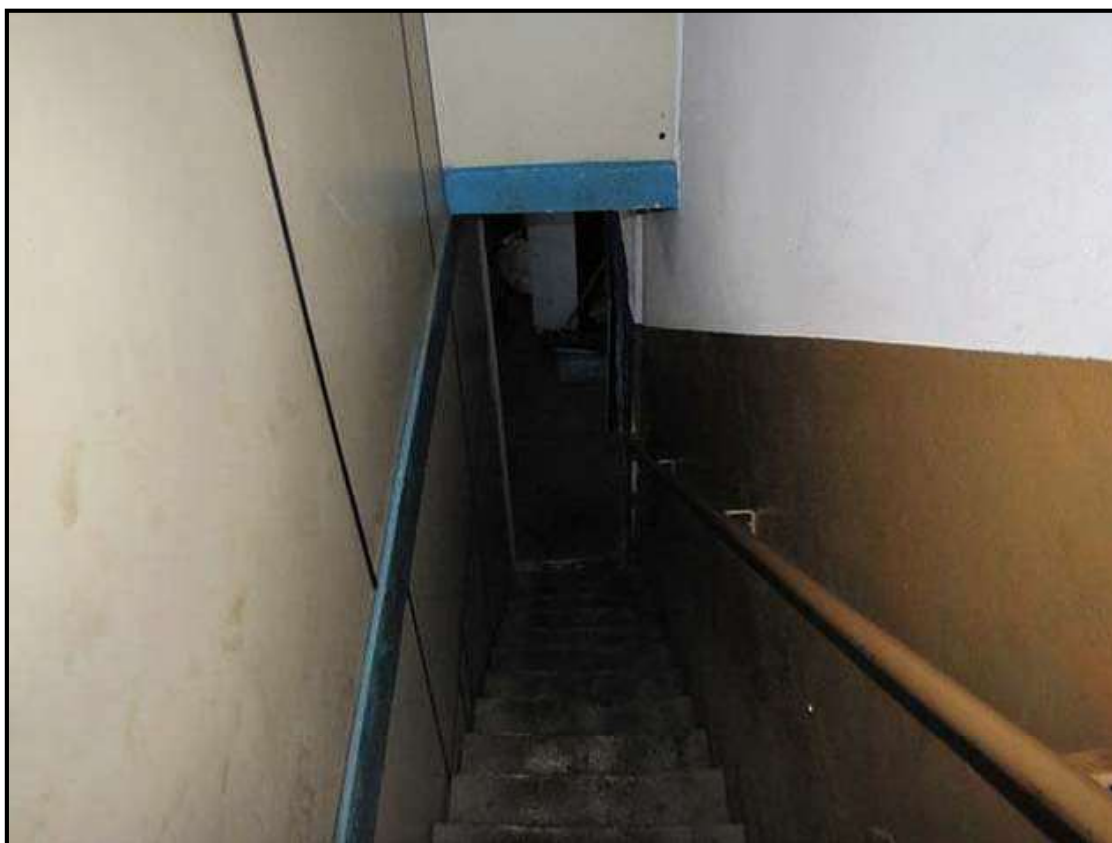
Escada de acesso ao pavimento superior
