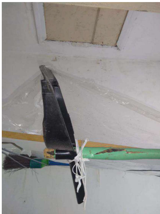
FOTO Nº 14 - Vista do plástico colocada pela moradora para captar a água de chuva que infiltra pelo alçapão.
