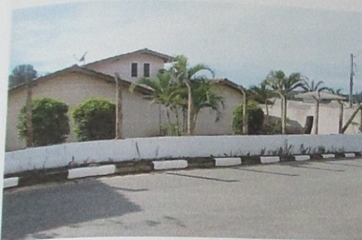
Figura 3 - Imóvel avaliando (matrícula 25862), visto da Rua Maria Clara Franco de Camargo.
