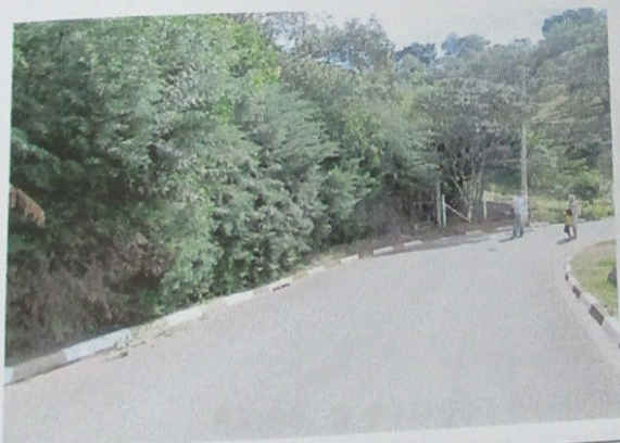
Figura 39 – Rua Gino Zilioli, nas proximidades do imóvel avaliando (matrícula 25868).
