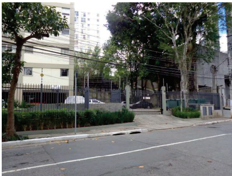
Fachada do condominio
