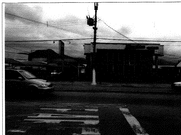
Vista Parcial da Fachada
