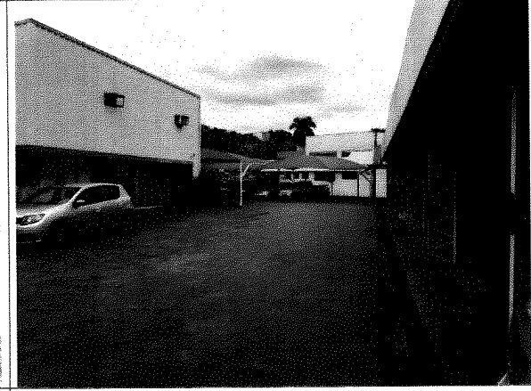
Vista parcial da Benfeitoria 2 (pavimentação)
