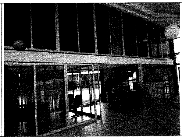
Vista interna da edificação
