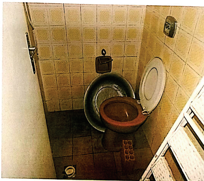
Foto 32 – Vista parcial sanitário 01
