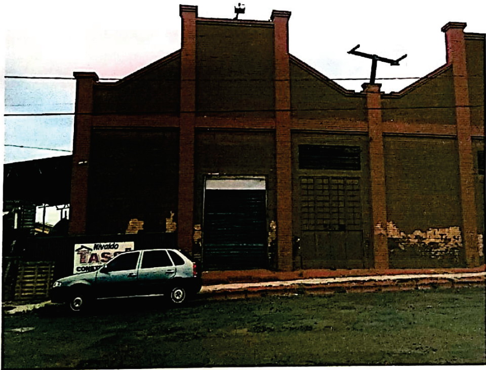
Foto 02 – Frente Rua Marcelino Rossini, 60
