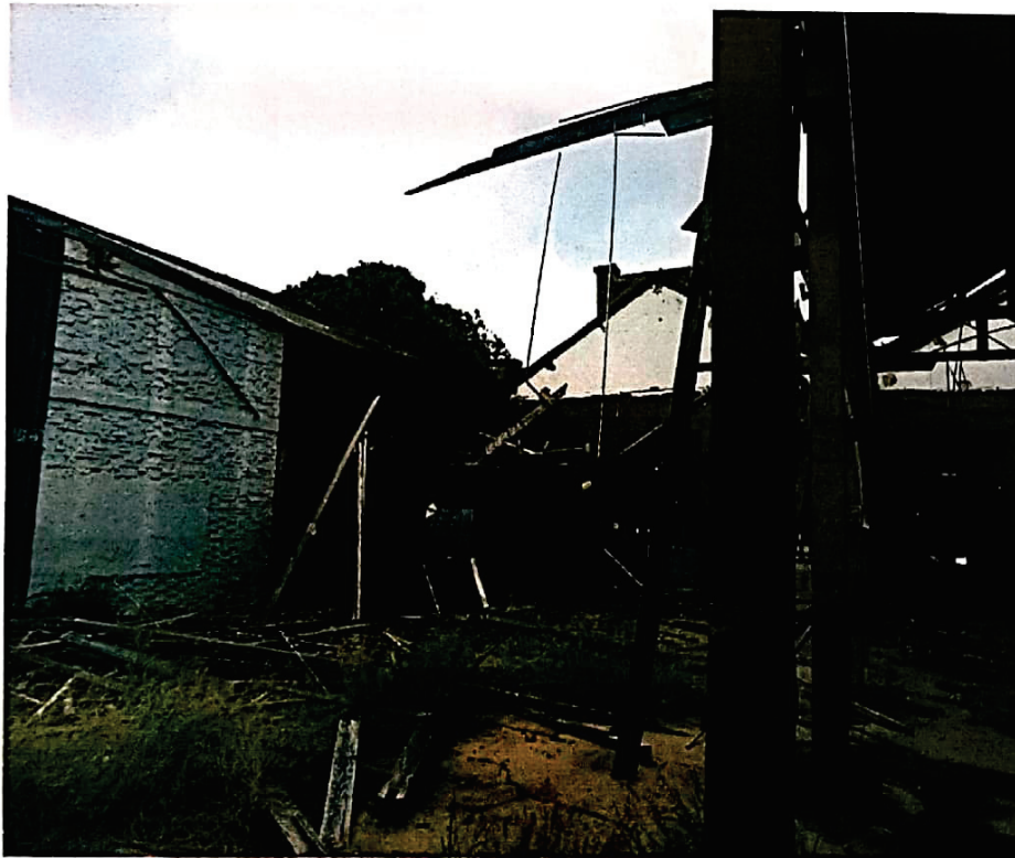
Foto 12 – Vista parcial interna
