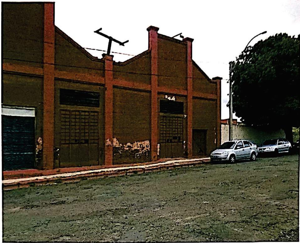
Foto 01 – Frente Rua Marcelino Rossini, 60
