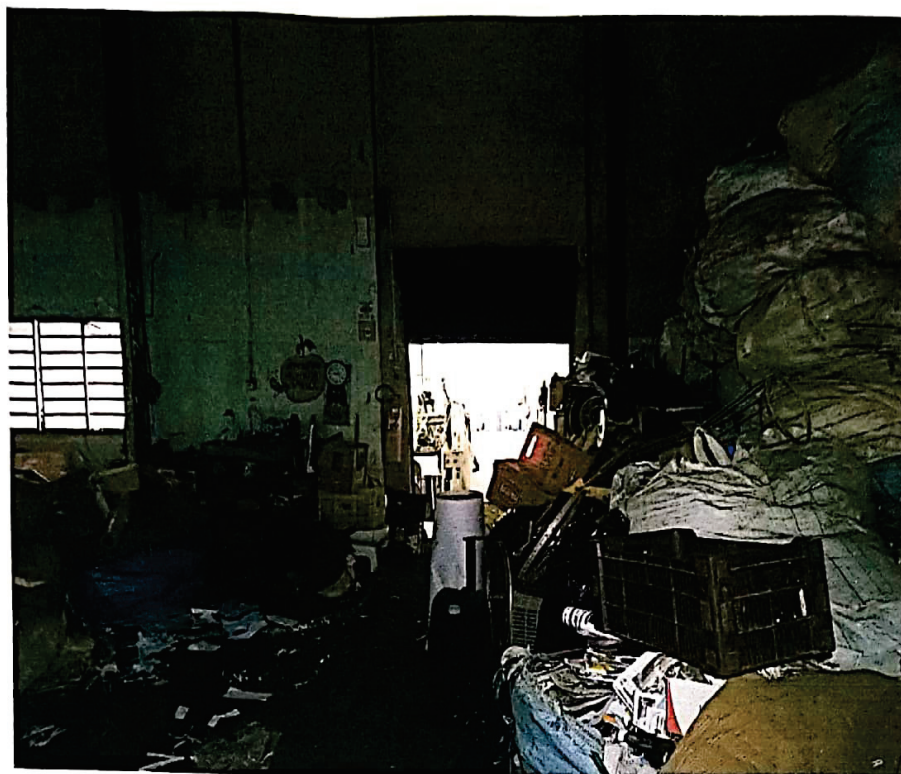
Foto 41 – Vista Interna porta de acesso lateral/escritório
