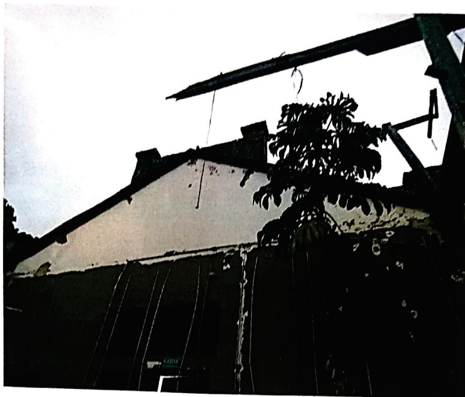
Foto 09 – Vista parcial Interna
