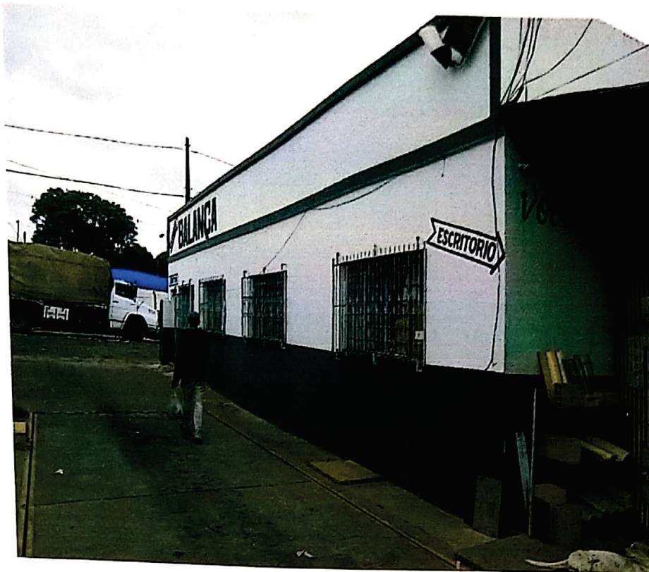
Foto 21 – Vista lateral fundo/frente escritório
