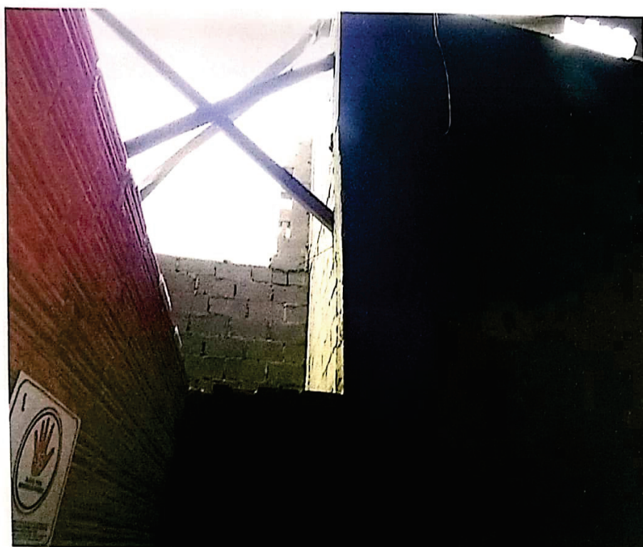
Foto 18 – Vista parcial interna
