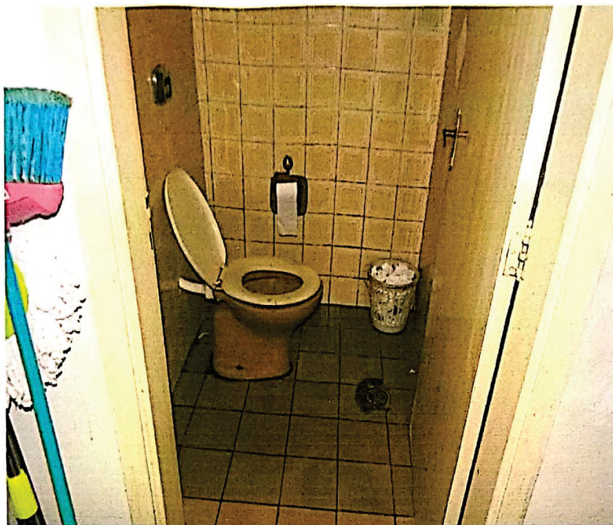
Foto 33 – Vista parcial sanitário 02
