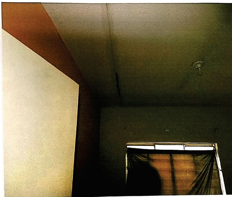
Foto 28 – Vista parcial teto sala 01
