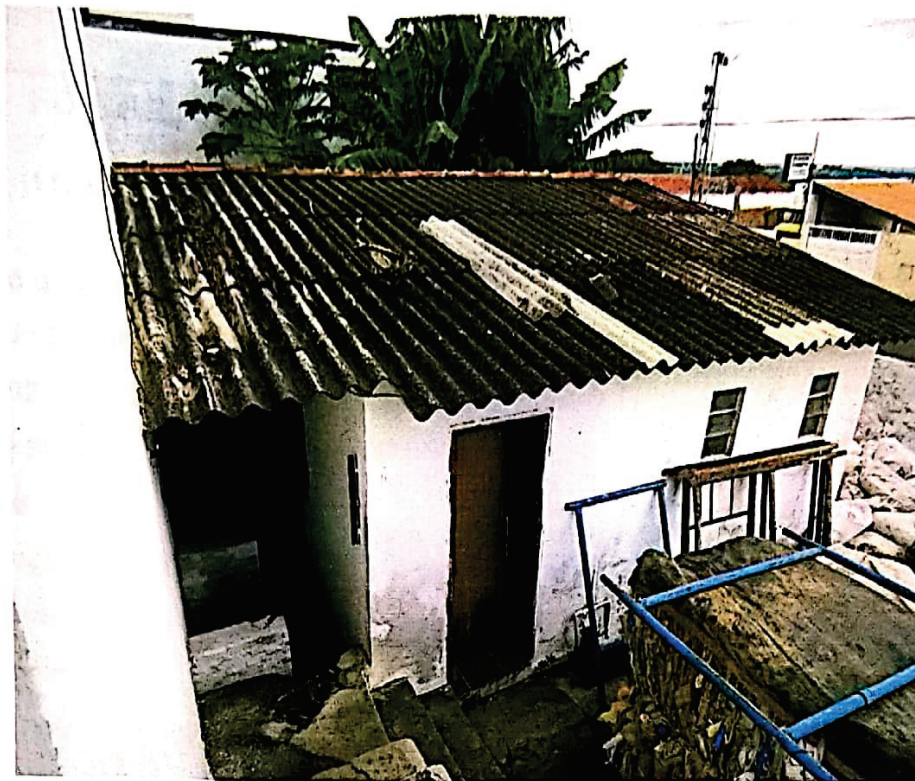
Foto 43 – Construção fundos barracão
