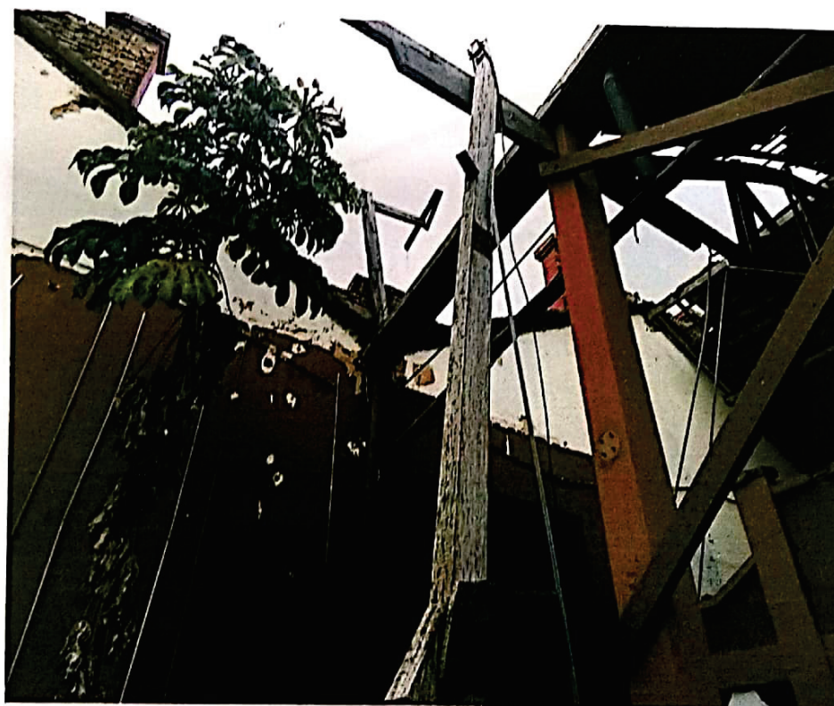
Foto 10 – Vista parcial Interna
