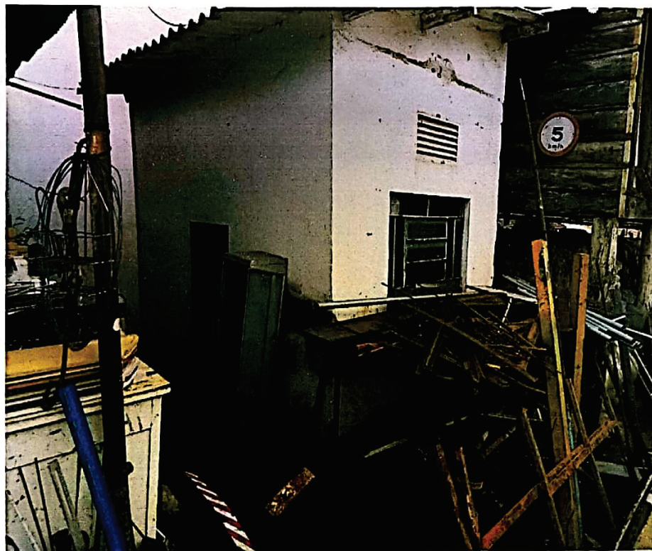
Foto 44 – Construção fundos escritório
