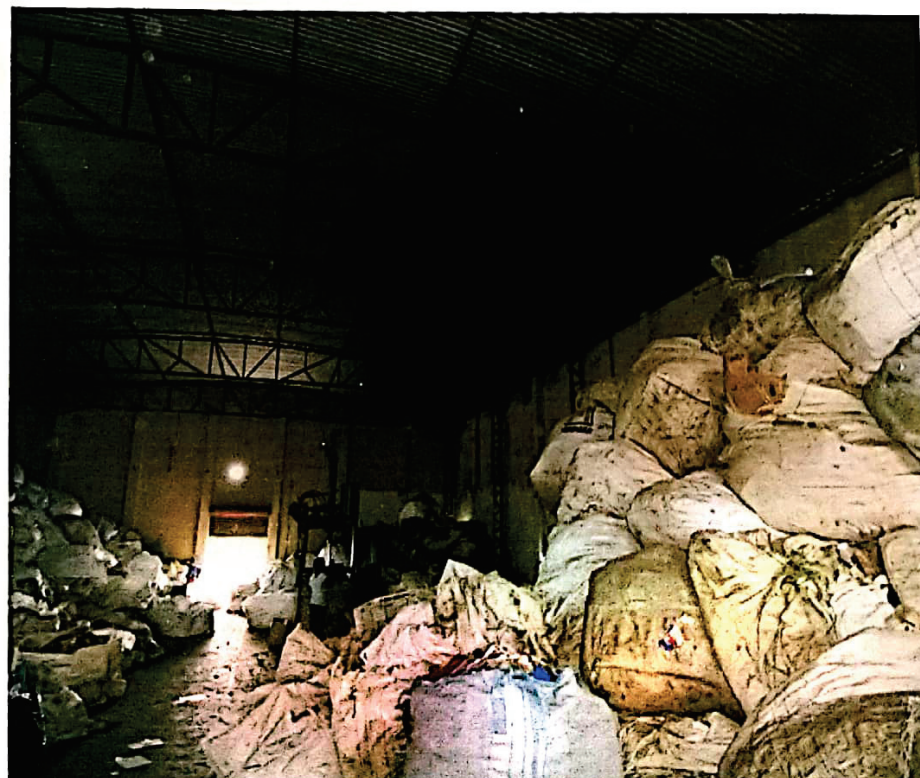
Foto 40 – Vista parcial cobertura metálica
