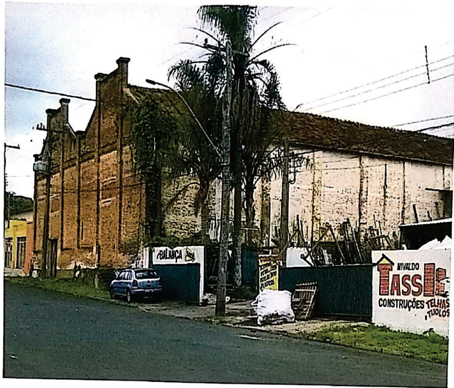
Foto 05 = Vista lateral fundos Rua Pará
