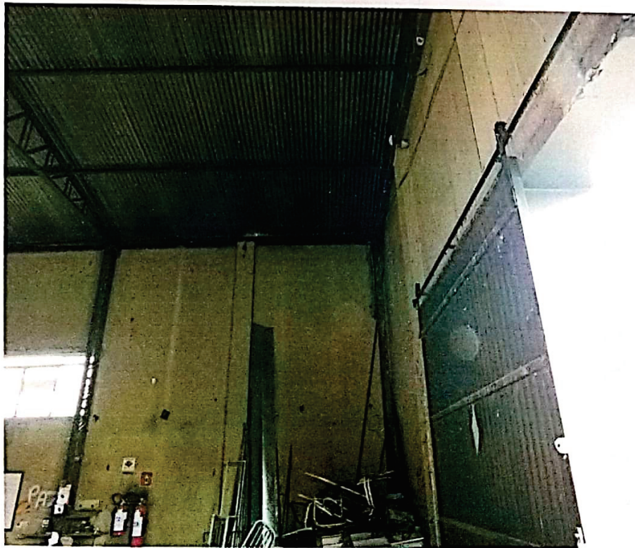
Foto 36 – Vista interna barracão
