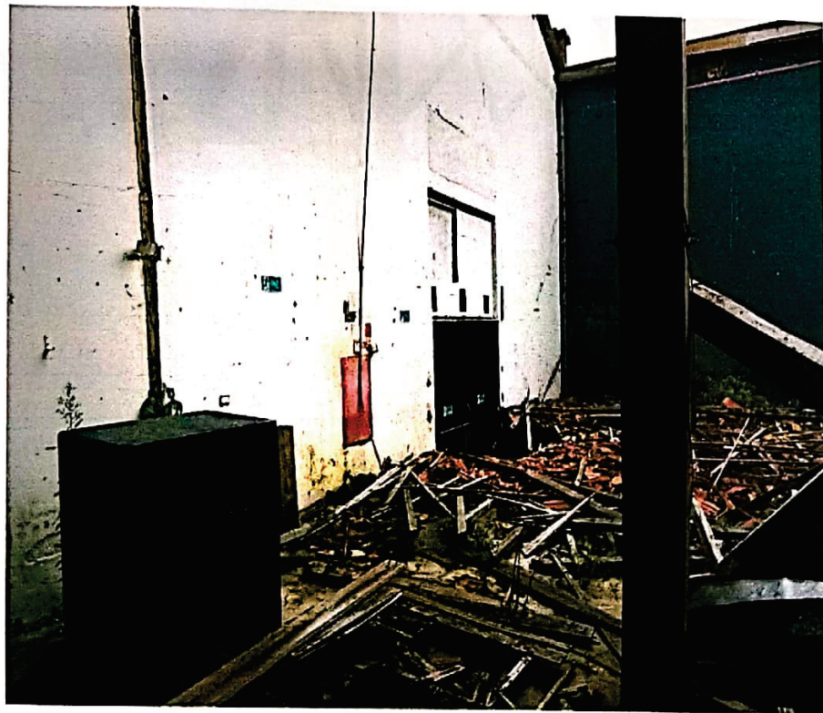
Foto 14 – Vista parcial interna
