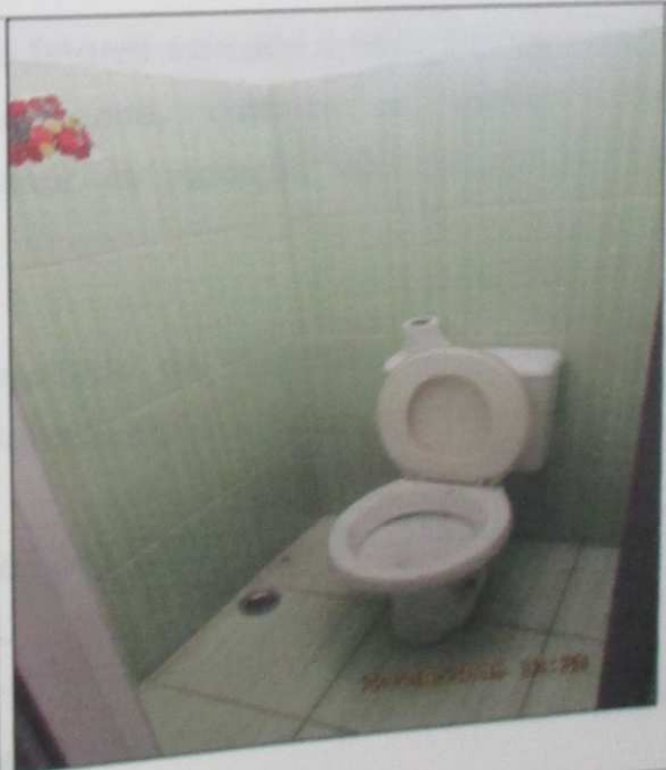
Foto 21- Vista do banheiro - 2.
