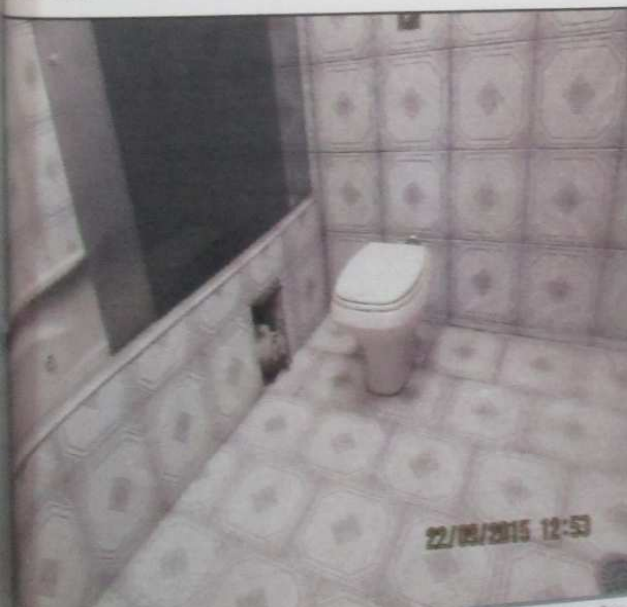
Foto 16- Vista do banheiro- pavimento superior
