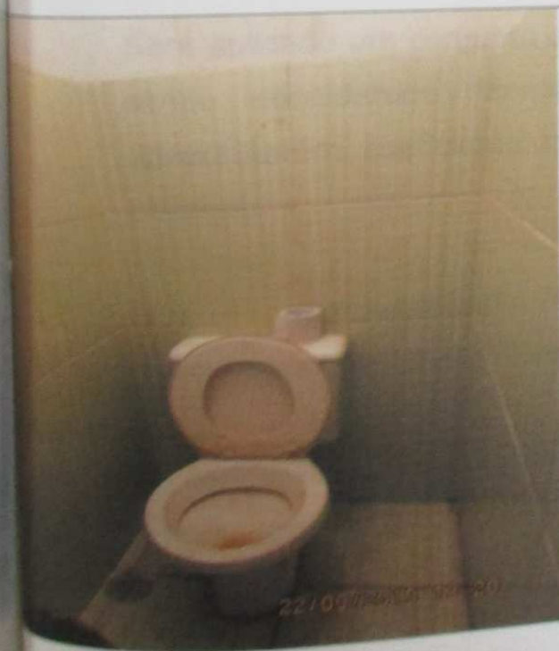
Foto 20 - Vista do banheiro - 1
