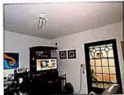
Vista Parcial de parede, teto e janela
