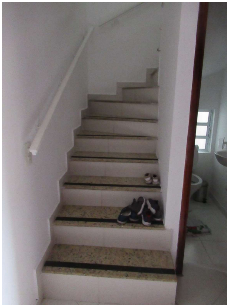
Foto nº. 14 – Vista da escada de acesso ao pavimento superior.
