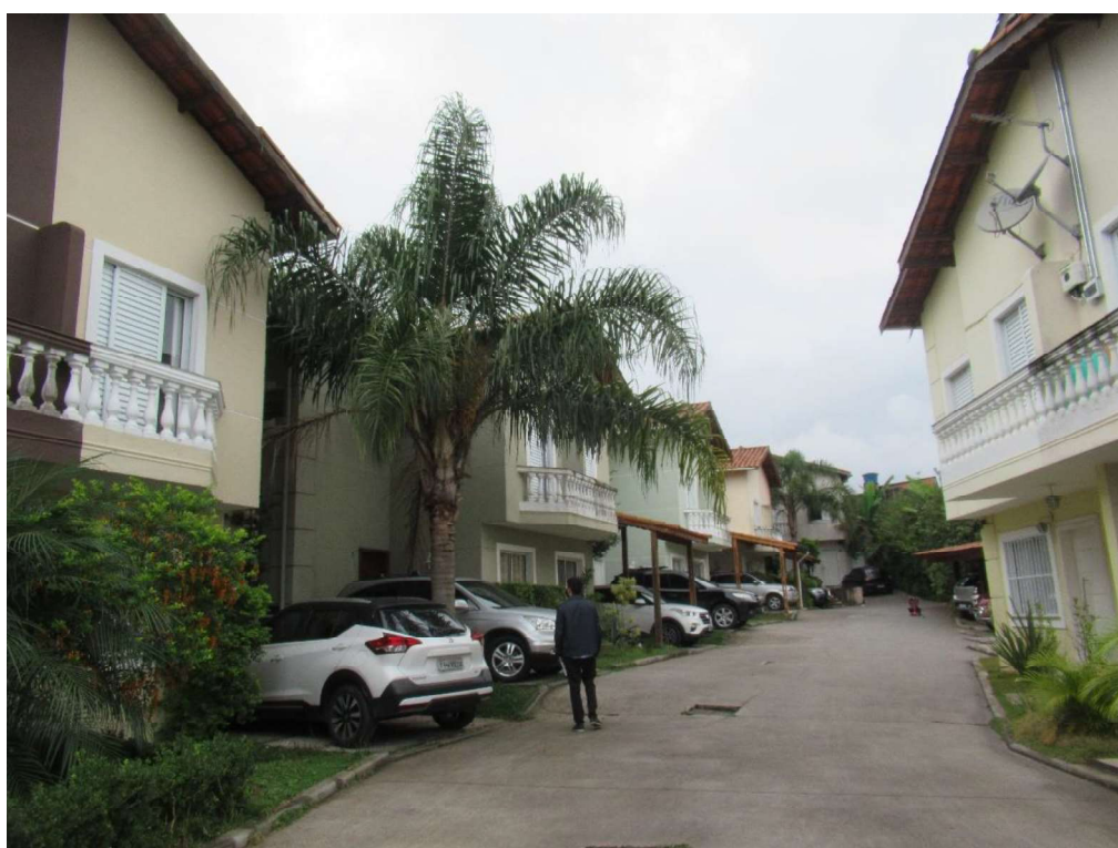
Foto nº. 5 – Vista da circulação de veículos.
