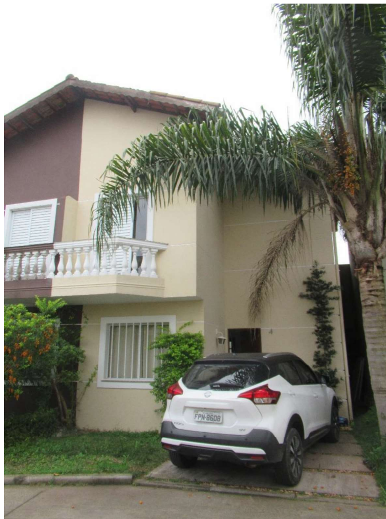
Foto nº. 7 – Vista da fachada do imóvel avaliando.
