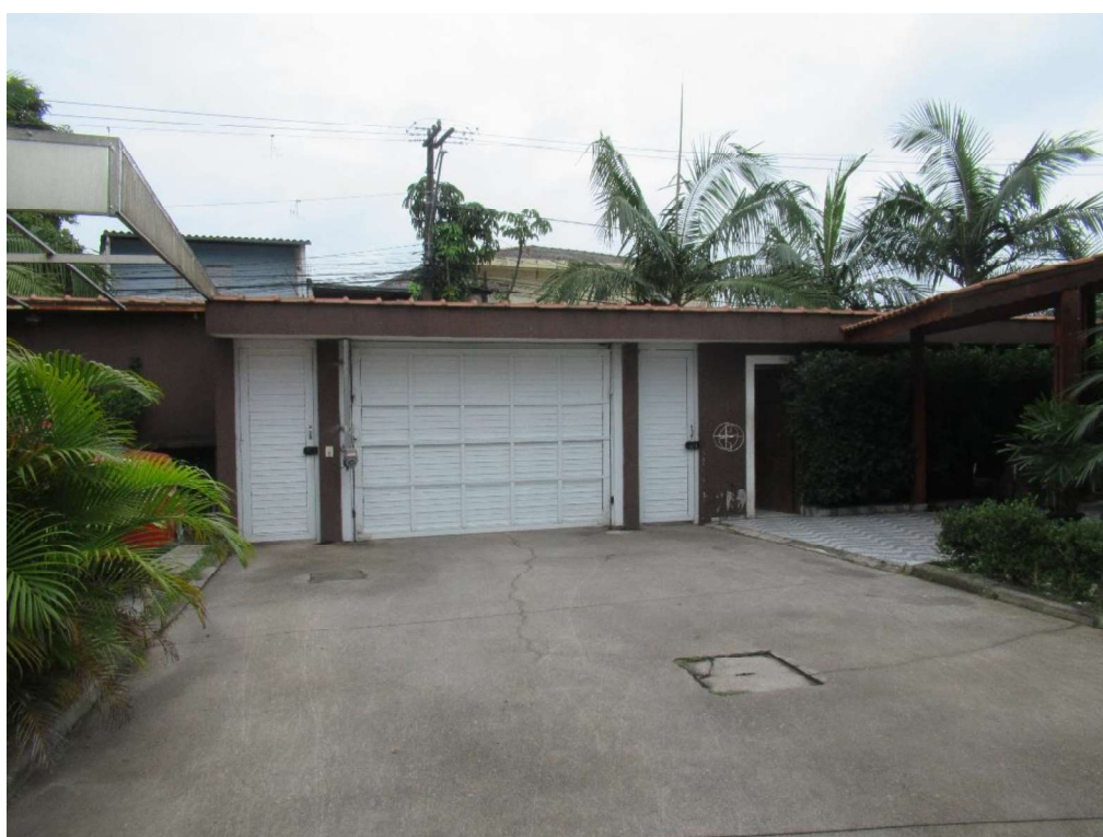
Foto nº. 4 – Vista interna da entrada do condomínio.
