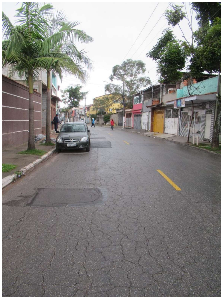
Foto nº. 2 – Outra vista da Rua Luar do Sertão.
