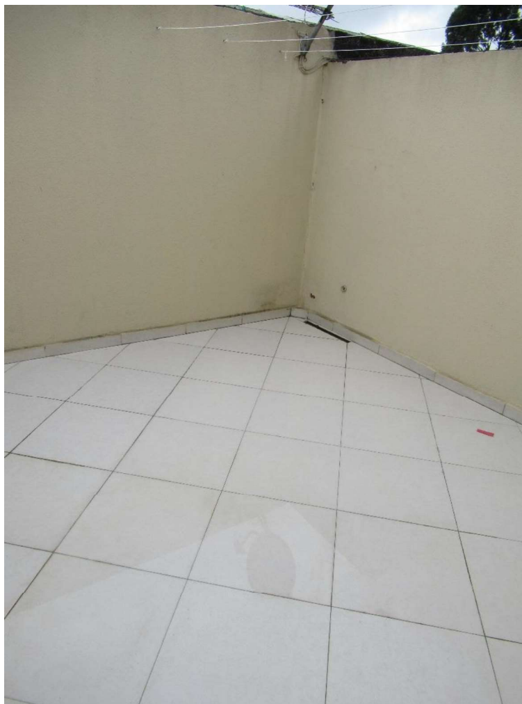
Foto nº. 18 – Vista do terraço.
