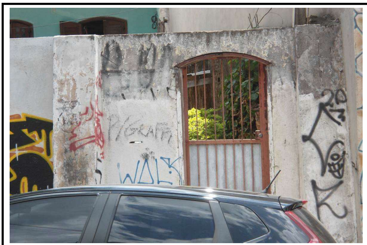
Foto nº 05: Vista do portão de acesso para transeuntes.
