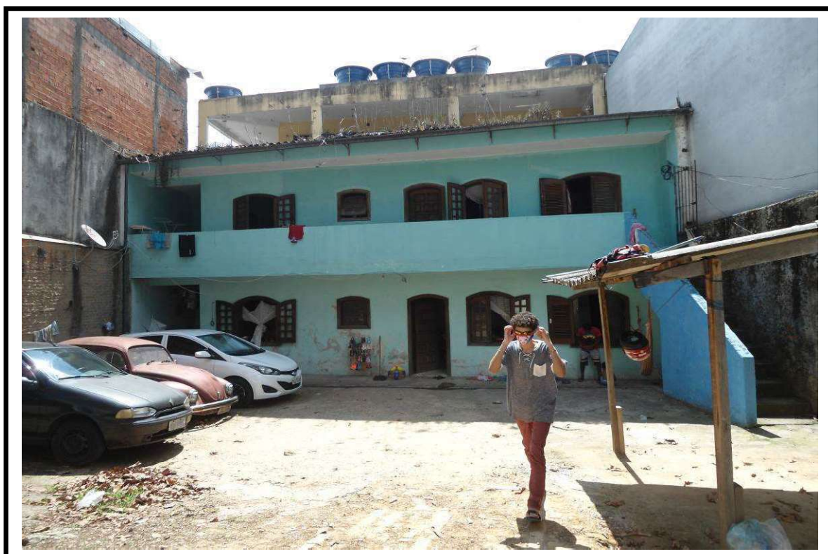
Foto nº 06: Vista interna do imóvel vendo-se a edificação existente. Trata-se de uma edificação erigida em alvenaria composta de 2 (dois) pavimentos.
