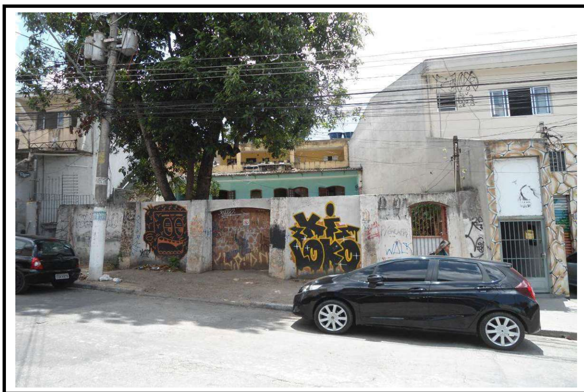
Foto nº 03: Vista da fachada do imóvel avaliando sob nº 18 da Rua Antonio José Bentes.
