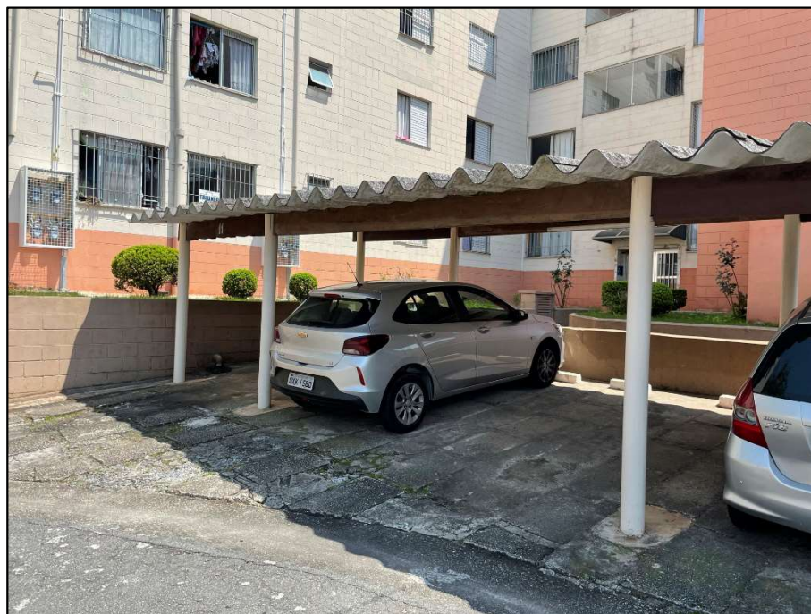
Foto 11 – CONDOMÍNIO RESIDENCIAL ITAPOAMA – Vaga de garagem
