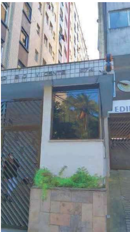
Imagem 1 Entrada principal do prédio.
