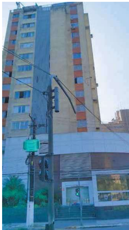
Imagem 4 Vista frontal do prédio.
