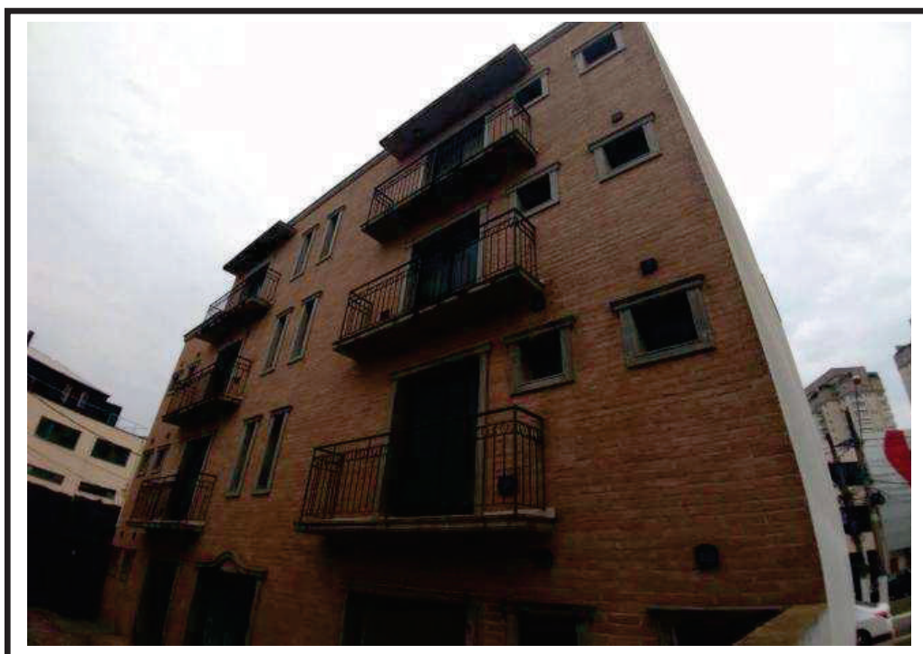
Foto nº 09: Vista de fachada, detalhe nos pavimentos superiores.
