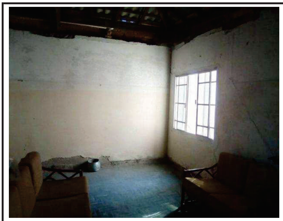
Foto nº 10: Vista da sala de estar.
