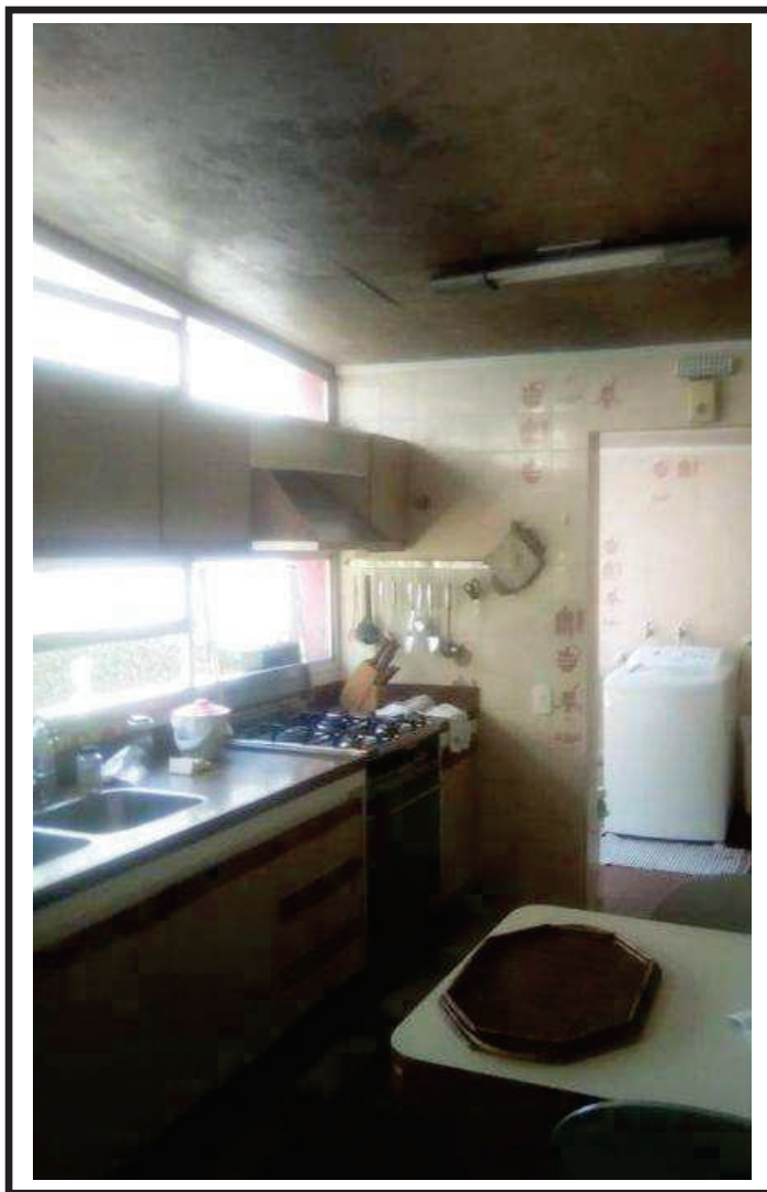
Foto nº 17: Vista da cozinha.
