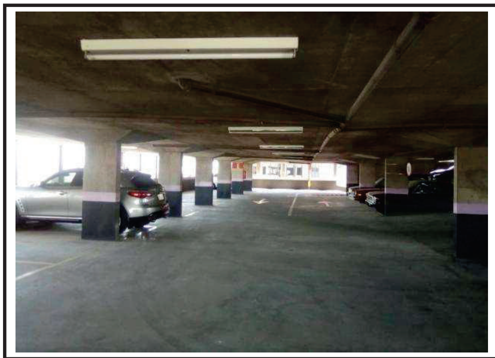
Foto nº 05: Vista da área do 8º andar.
