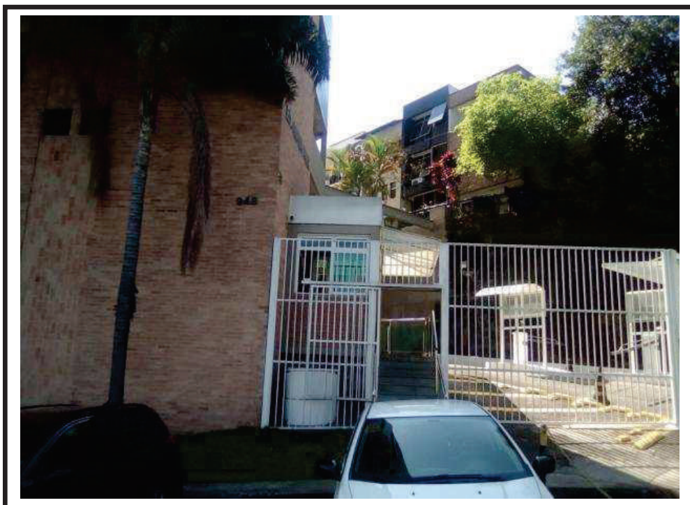
Foto nº 04 Vista da entrada do edifício onde se localiza os imóveis avaliados.
