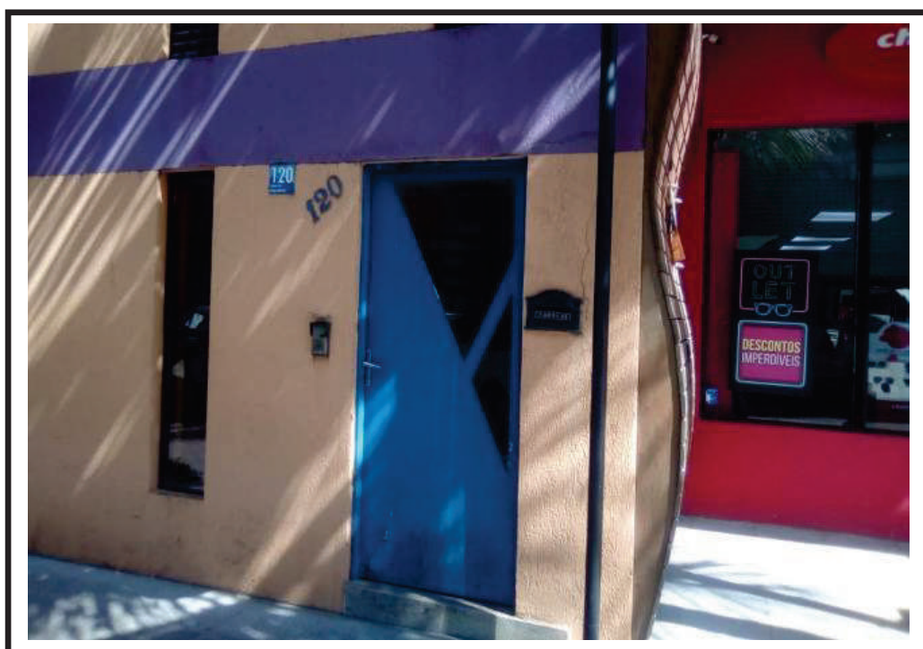
Foto nº 06: Vista da entrada para os pavimentos superiores do imóvel avaliando. O observador encontra-se na lateral do imóvel, defronte ao nº 120 na Calçada das Orquídeas.
