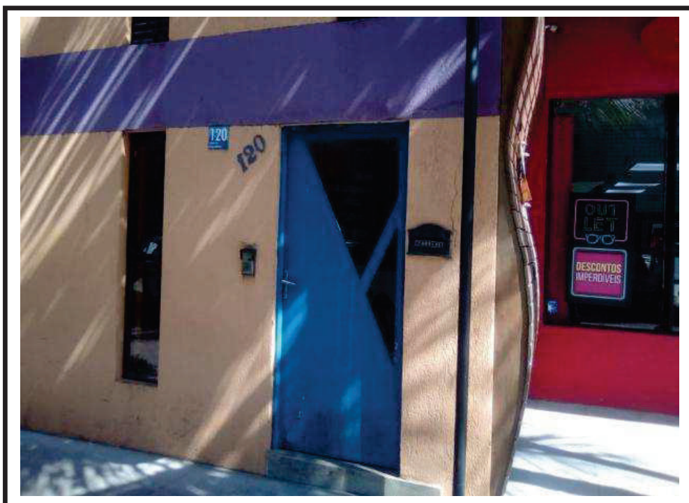
Foto nº 04 Vista da entrada para os pavimentos superiores do imóvel avaliando.
