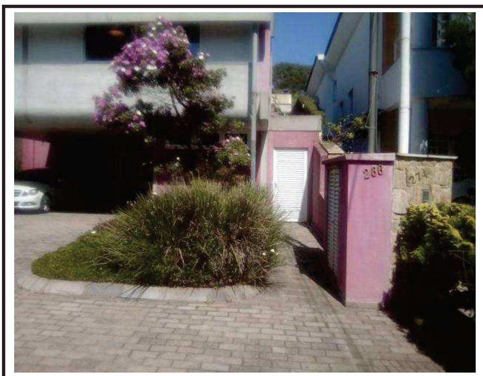
Foto nº 04: Vista da entrada do imóvel, objeto da presente ação.
