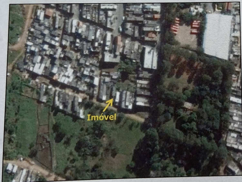
Figura 2: Vista aérea da região
