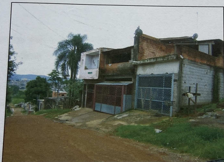
Foto 01: Vista da frente do avaliando
