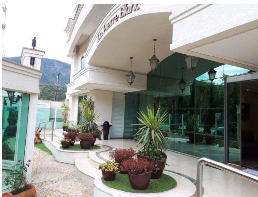
Foto 06 – Entrada do prédio
