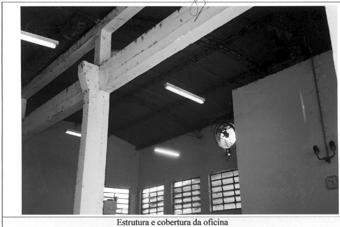
Oficina – anexo ao acabamento 2 – interna
