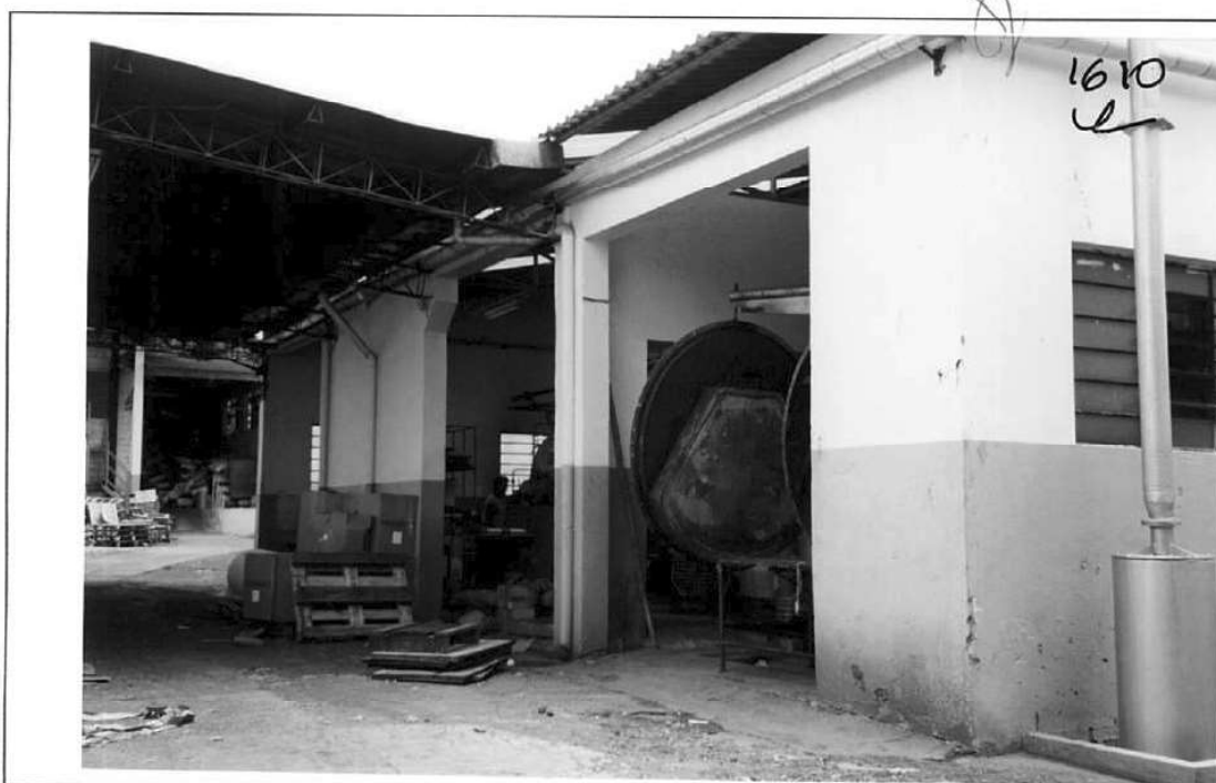
Fachada do prédio das caldeiras
