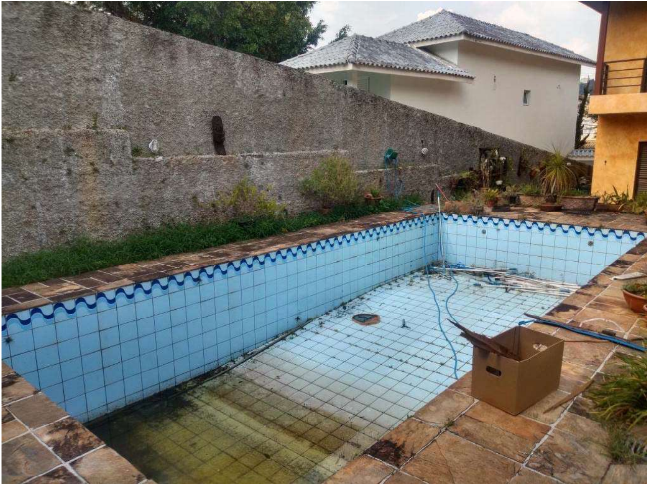
FOTO 58: OUTRA VISTA DA PISCINA DO IMÓVEL.
