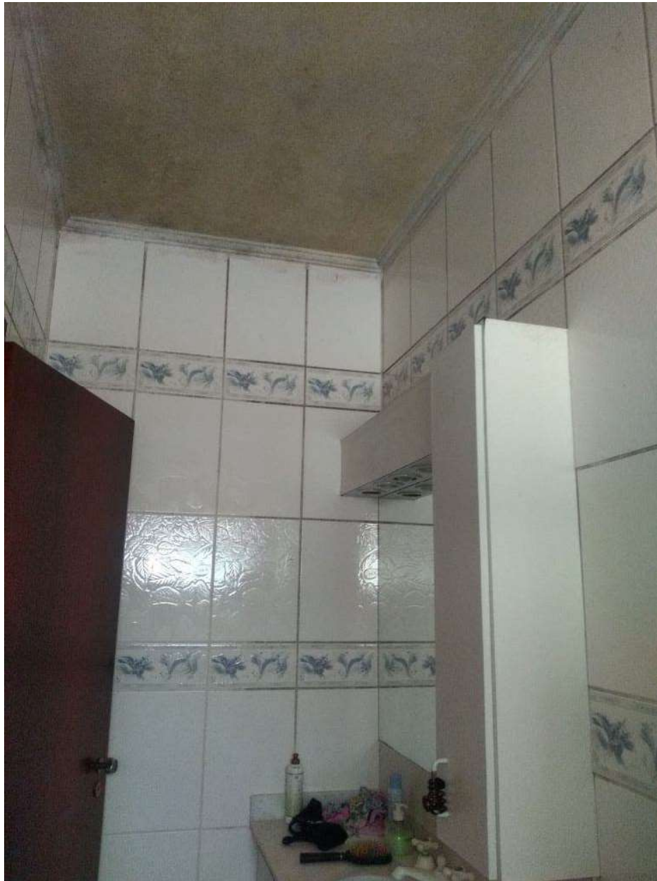
FOTO 48: OUTRA VISTA INTERNA DO BANHEIRO DA SUÍTE 4.
