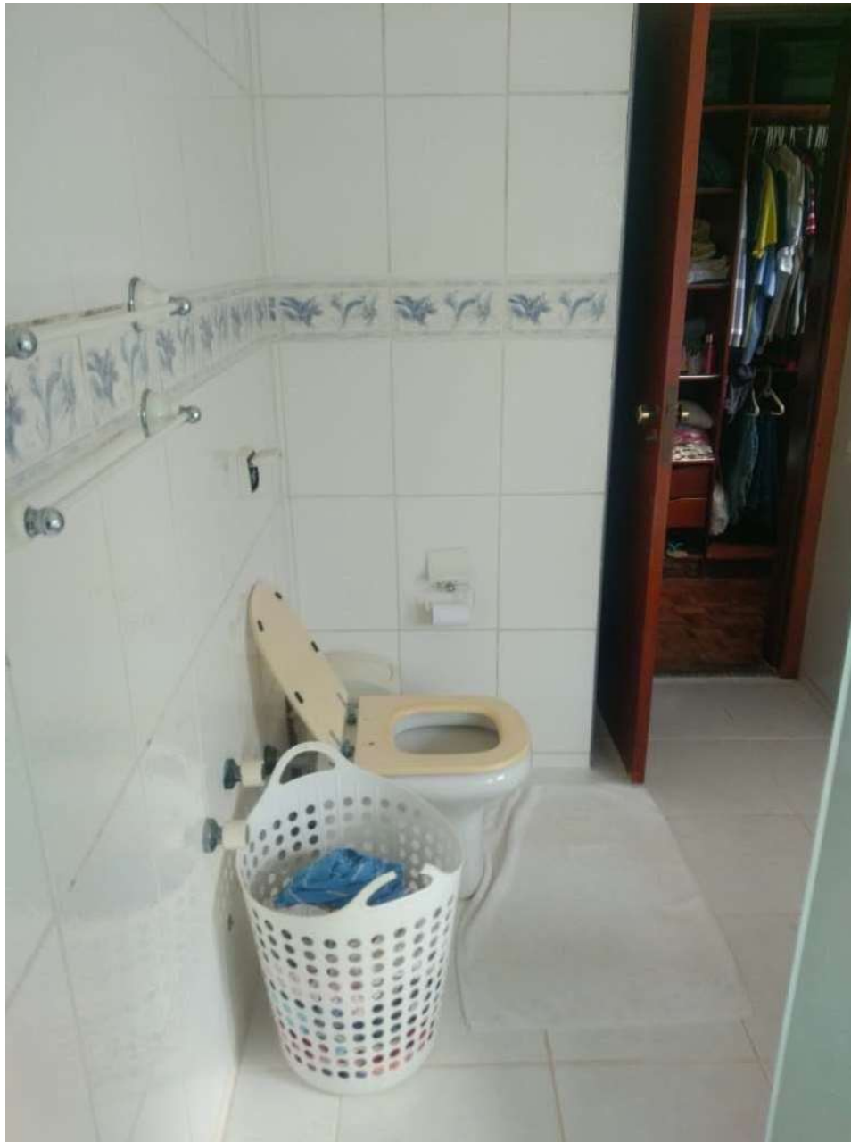
FOTO 56: OUTRA VISTA INTERNA DO BANHEIRO DA SUÍTE MASTER.
