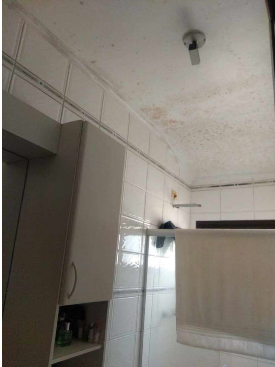
FOTO 35: OUTRA VISTA INTERNA DO BANHEIRO DA SUÍTE 1.
