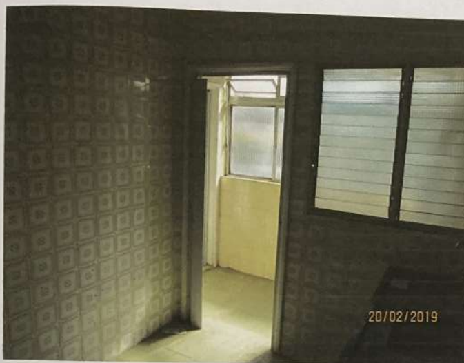
Foto 17) Outra vista do interior da cozinha, agora visando a comunicação com a área de serviço. Observar acabamento de piso e paredes e parte do caixilho da área de serviço.
