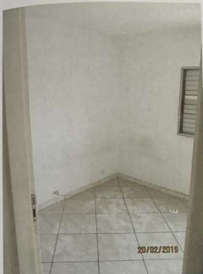
Foto 21) Vista do interior de um dos dormitórios. Observar acabamento e parte do caixilho em alumínio anodizado natural e PVC.
