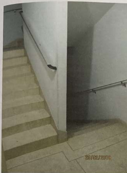
Foto 13) Vista da escada de uso comum no 2º andar do edifício. Observar acabamento e corrimãos em alumínio anodizado natural.
