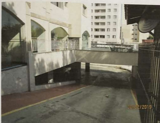
Foto 05) Vista da rampa de acesso de autos ao subsolo, destinado ao estacionamento de veículos e contando com piscina e quadra poliesportiva.
