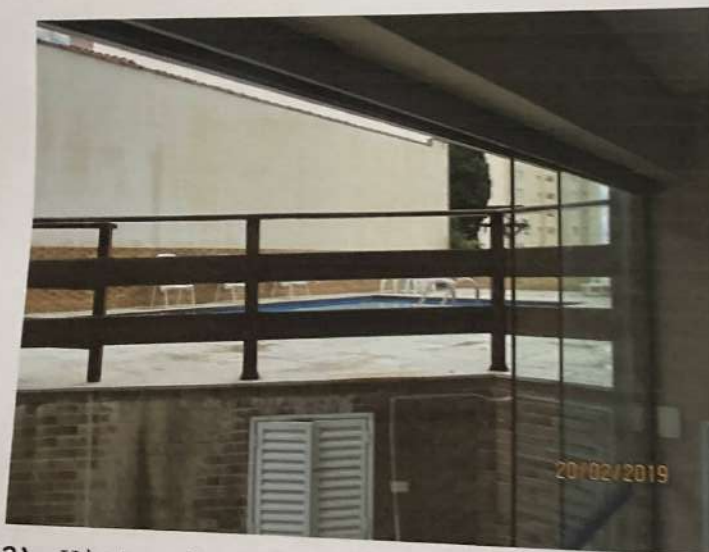
Foto 33) Vista da área de piscina no piso térreo.
