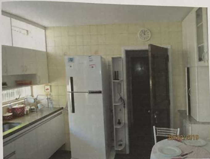
Foto 40) Vista da cozinha. Observar acabamento de piso, paredes e teto, pia com tampo em granito sobre gabinete em fórmica e porta comunicando o hall de serviço.
