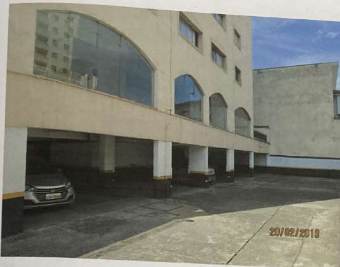
Foto 07) Outra vista da área do subsolo destinada ao estacionamento de veículos e, também, de parte da elevação de fundos do edifício.
