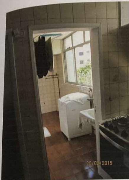
Foto 44) Outra vista da cozinha, agora visando a área de serviço. Observar acabamento e caixilho em alumínio anodizado natural.
