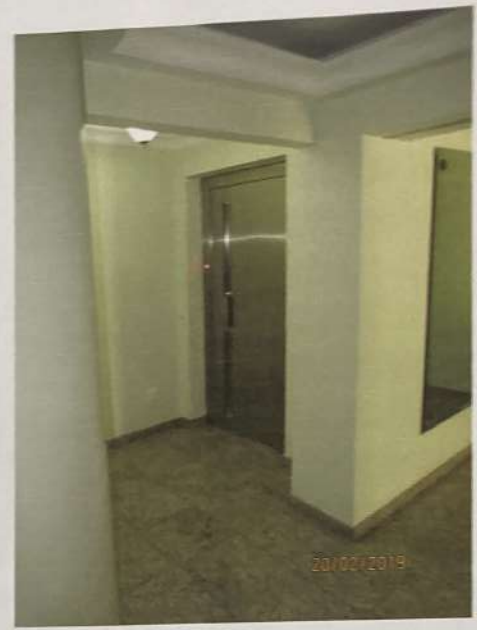
Foto 30) Vista do hall social. Observar acabamento de piso, paredes e teto.
