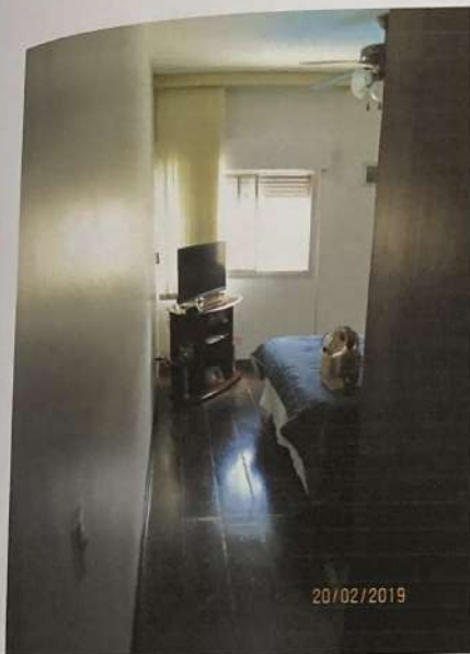
Foto 56) Vista da de parte do dormitório. Observar acabamento de piso paredes e teto e janelas de enrolar com abertura e fechamento por cinta lateral.
