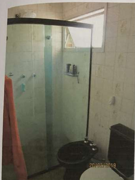
Foto 52) Outra vista do banheiro. Observar acabamento de piso e paredes, peças sanitárias, área de banho com fechamento em vidro e alumínio e caixilho em alumínio anodizado natural, tipo "maxim-ar".
