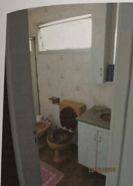
Foto 54) Vista do banheiro suíte, localizado à direita de quem adentra ao dormitório. Observar acabamento, peças sanitárias e caixilho.
