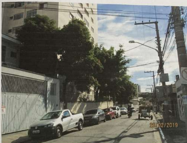
Foto 01) Vista da Avenida Lasar Segall, em direção à Avenida Imirim. Observar via em aclive suave, asfaltada, de gabarito reduzido e ocupação majoritariamente horizontal.
