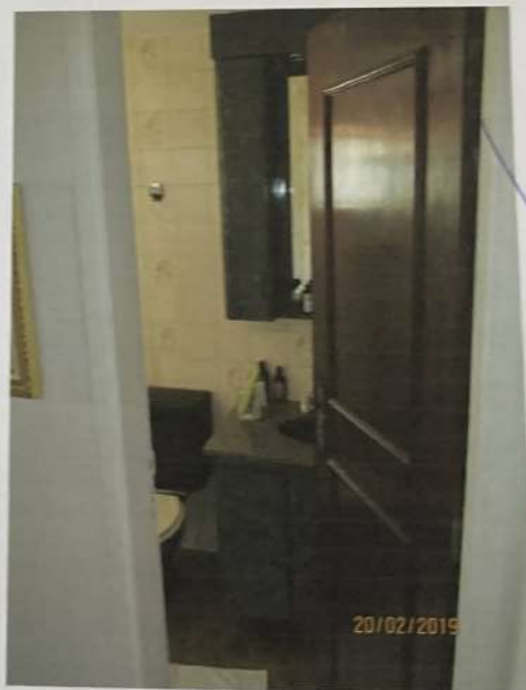
Foto 51) Vista do banheiro. Observar acabamento de piso e paredes, pia com tampo em granito sobre gabinete em fórmica e parte da bacia sanitária com caixa acoplada.
