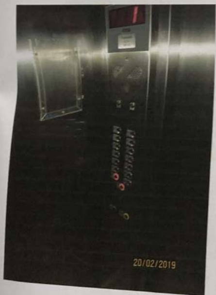
Foto 31) Vista do interior da cabine do elevador, em aço inoxidável escovado.
