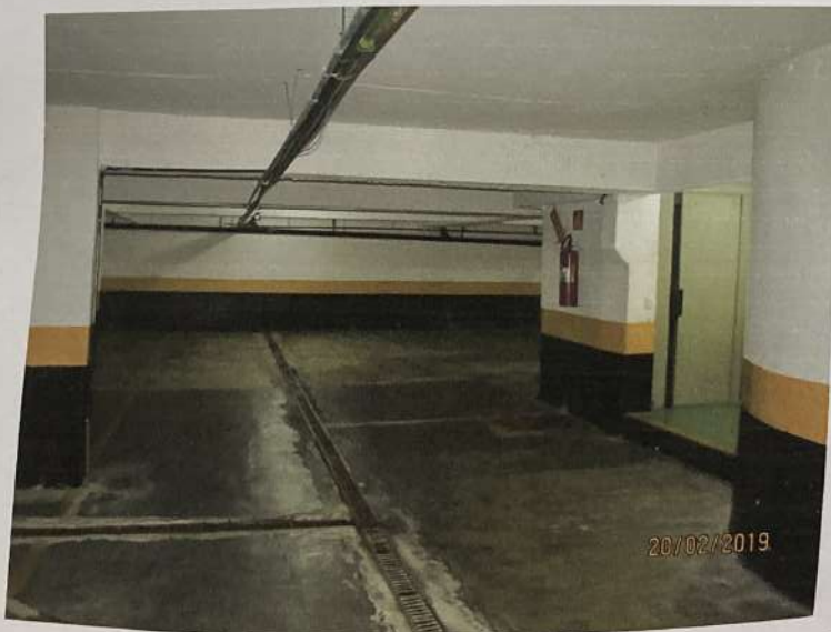
Foto 35) Vista da garagem no 2º subsolo. Observar hall de elevador, acabamento e pintura de segurança em conformidade com as Normas.
