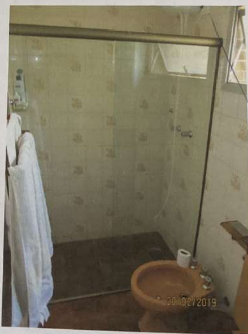
Foto 55) Outra vista do banheiro. Observar área de banho com fechamento em vidro e alumínio.
