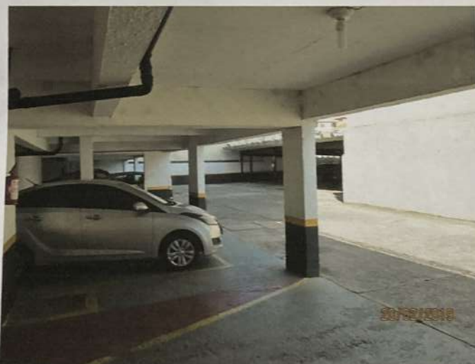
Foto 06) Vista da área do subsolo destinada ao estacionamento de veículos.
