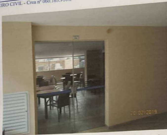
Foto 32) Vista no piso térreo do salão de festas do edifício. Observar acabamento de piso, paredes e teto das dependências.
