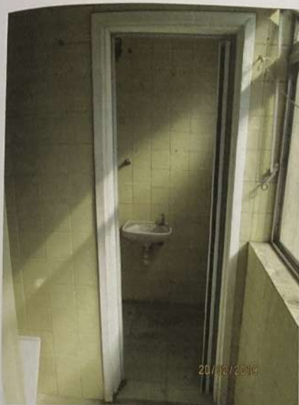
Foto 19) Vista do banheiro de serviço. Observar acabamento e pia de pequenas dimensões
