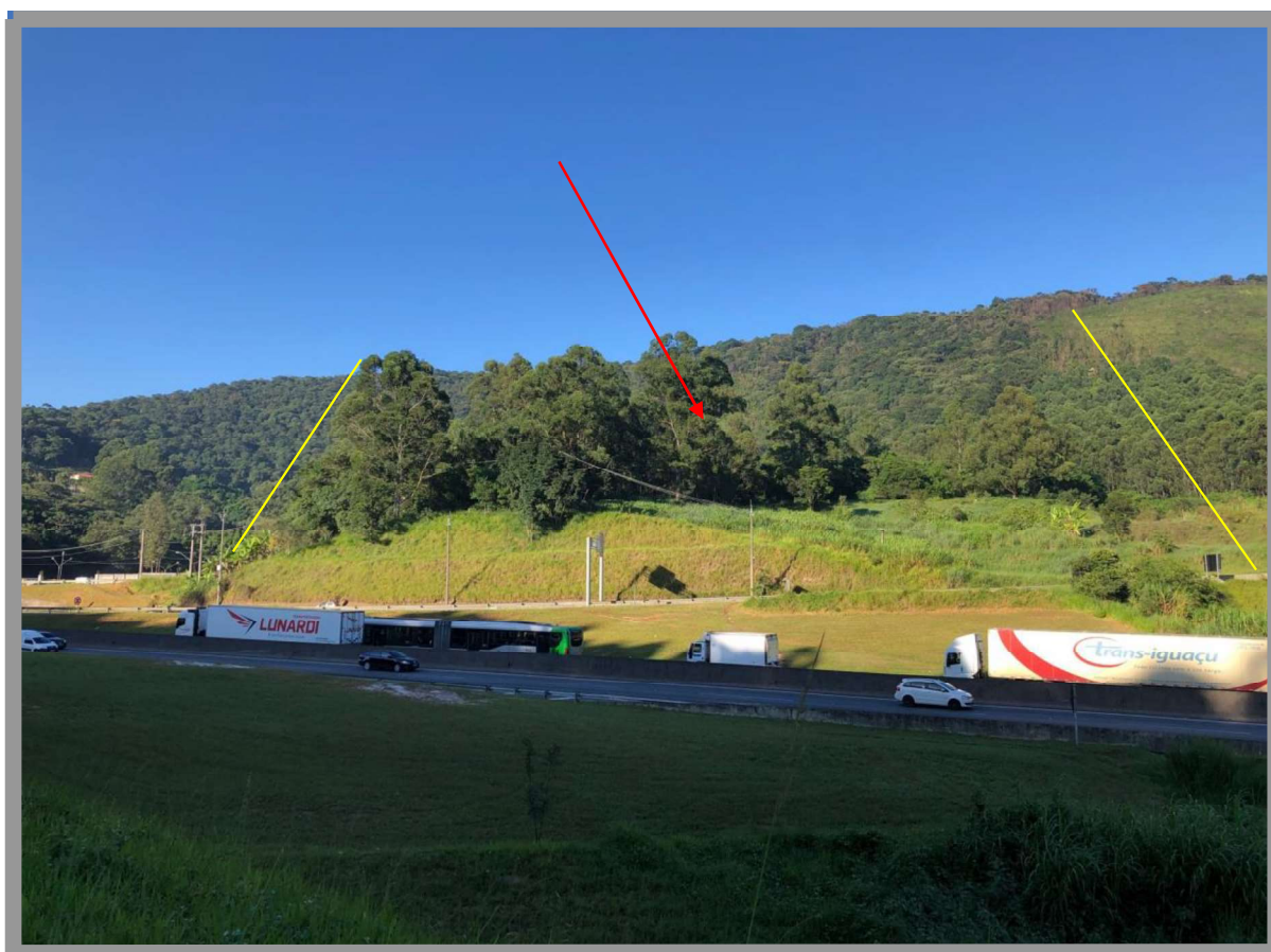
Vista da fachada da área avalianda a partir da alça de acesso da Rodovia Anhanguera para o Rodoanel Mario Covas.
