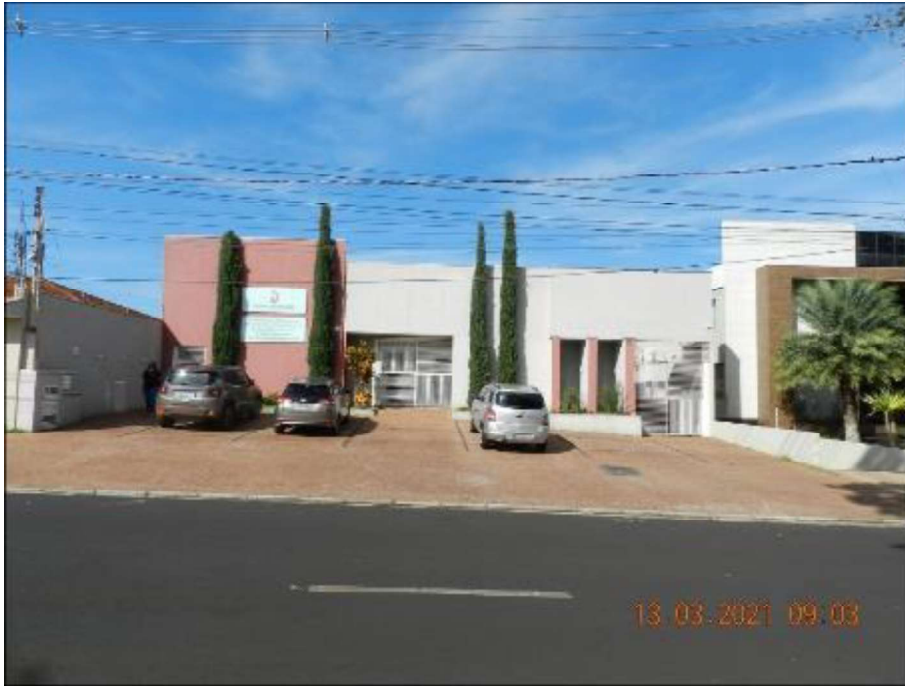
Fachada do imóvel avaliando
