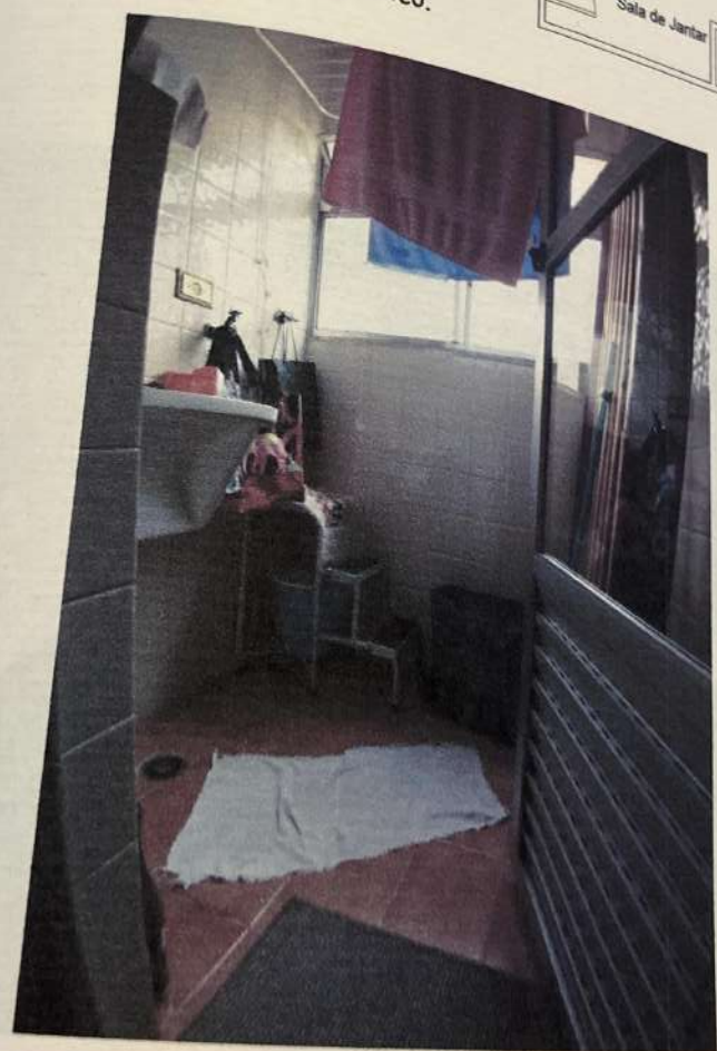
VISTA DO PADRÃO CONSTRUTIVO DA ÁREA DE SERVIÇO.
