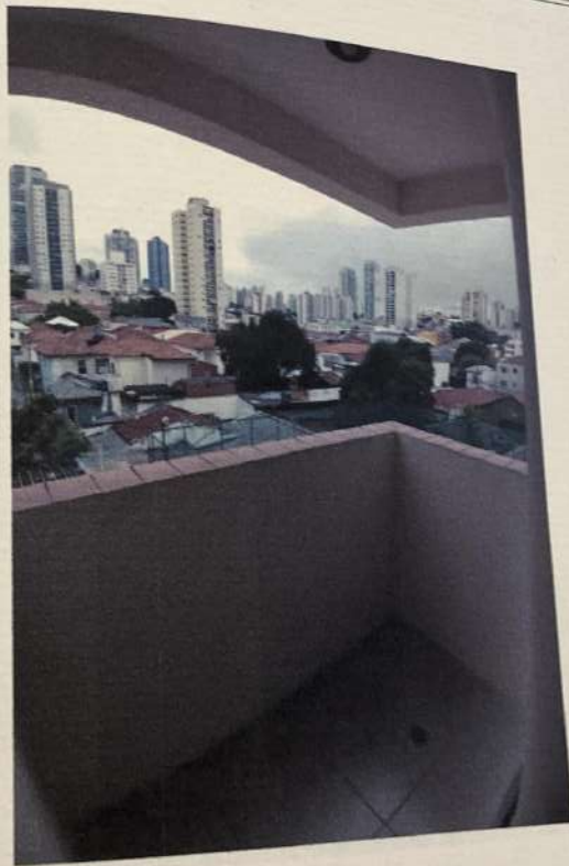
VISTA DO PADRÃO CONSTRUTIVO DA SACADA.
