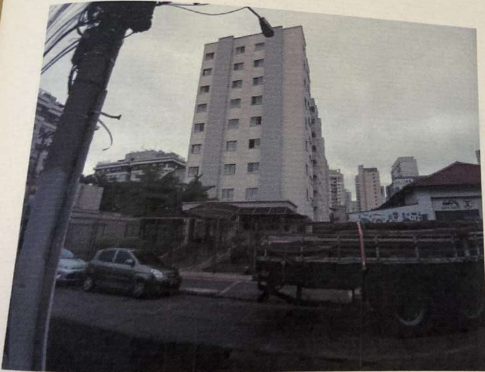
VISTA DA FACHADA DO CONDOMÍNIO ONDE SE LOCALIZA A UNIDADE AVALIANDA.
