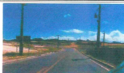
RN 160 COM IMÓVEL AO FUNDO
