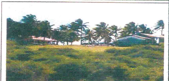
ASPECTO DAS CONSTRUÇÕES EM DEMOLIÇÃO
