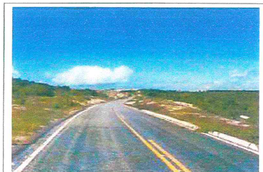
RN 160 CORTANDO O IMÓVEL NO SENTIDO SUL
