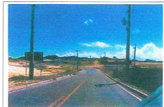
RN 160 COM IMÓVEL AO FUNDO
