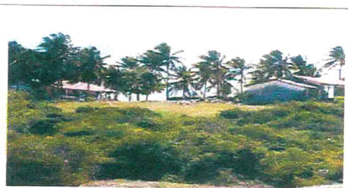
ASPECTO DAS CONSTRUÇÕES EM DEMOLIÇÃO
