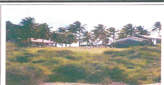
ASPECTO DAS CONSTRUÇÕES EM DEMOLIÇÃO
