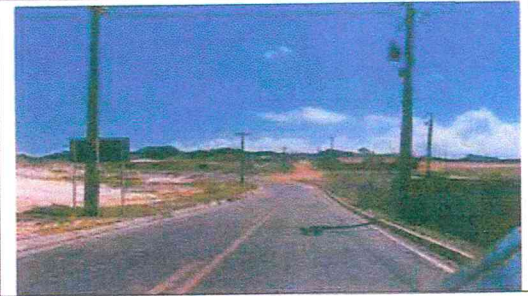
RN 160 COM IMÓVEL AO FUNDO
