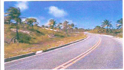
RN 160 ATRAVESSANDO O COQUEIRAL NO IMÓVEL
