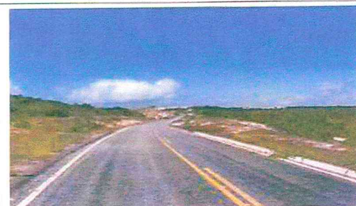
RN 160 CORTANDO O IMÓVEL NO SENTIDO SUL
