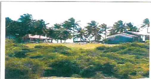
ASPECTO DAS CONSTRUÇÕES EM DEMOLIÇÃO
