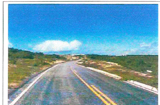
RN 160 CORTANDO O IMÓVEL NO SENTIDO SUL
