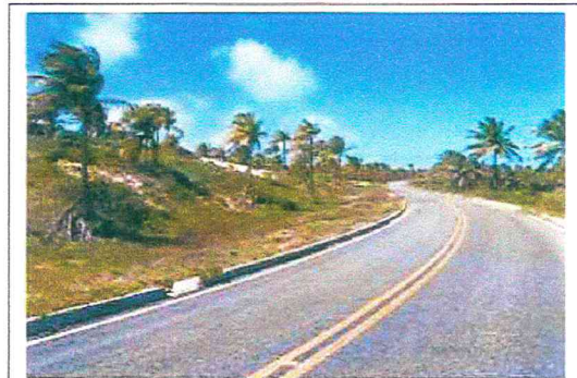
RN 160 ATRAVESSANDO O COQUEIRAL NO IMÓVEL
