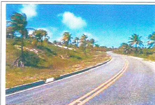
RN 160 ATRAVESSANDO O COQUEIRAL NO IMÓVEL
