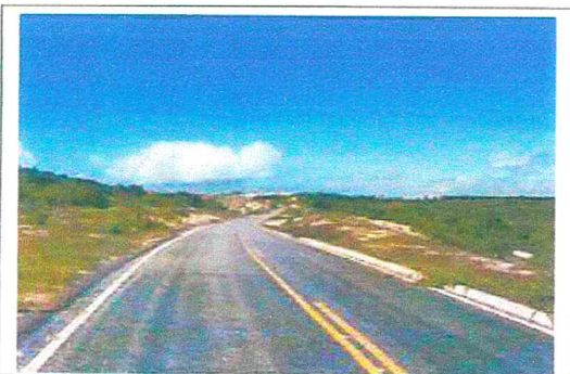
RN 160 CORTANDO O IMÓVEL NO SENTIDO SUL
