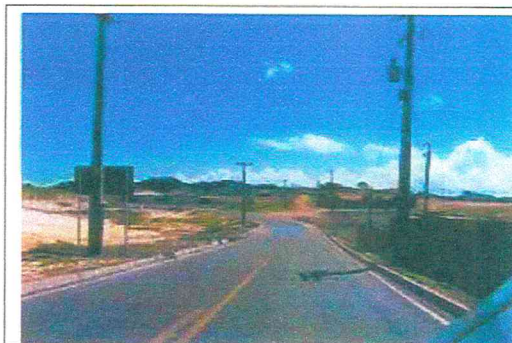
RN 160 COM IMÓVEL AO FUNDO
