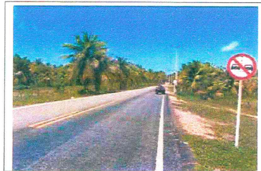
RN160 JUNTO A DIVISA DO EXTREMO NORTE DO IMÓVEL
