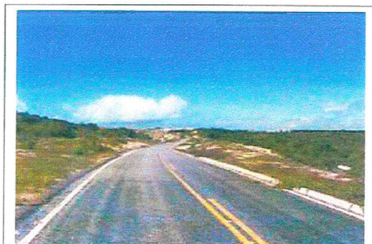
RN 160 CORTANDO O IMÓVEL NO SENTIDO SUL
