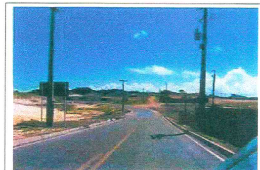
RN 160 COM IMÓVEL AO FUNDO
