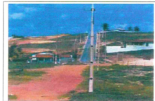
RN 160 NAS PROXIMIDADES DO IMÓVEL
