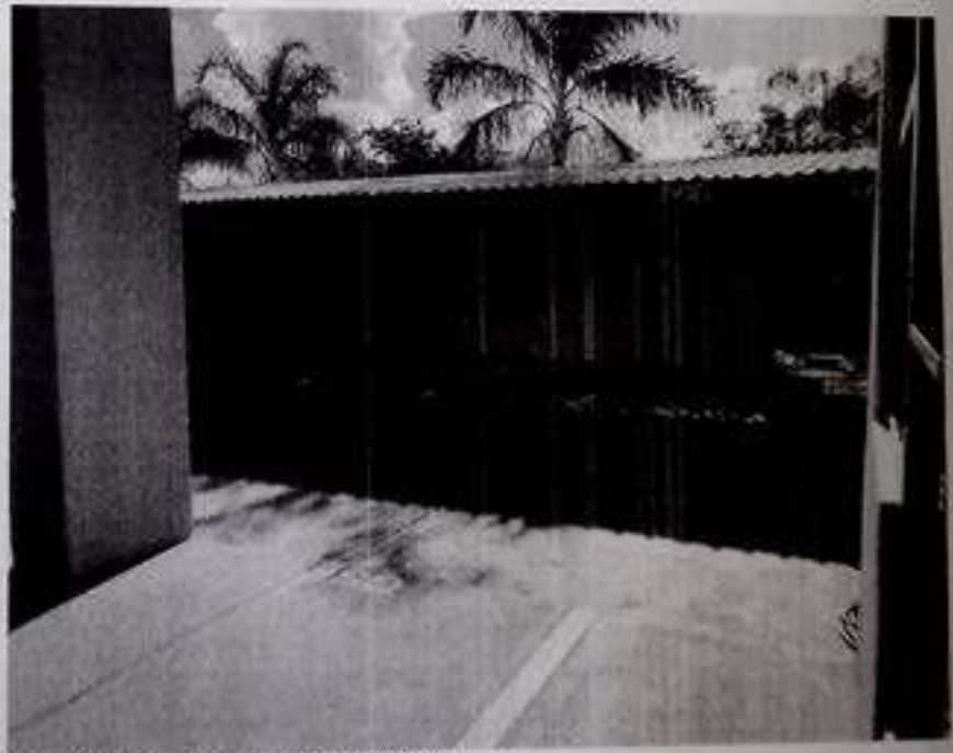
Foto 02: Vista da garagem do Edifício
