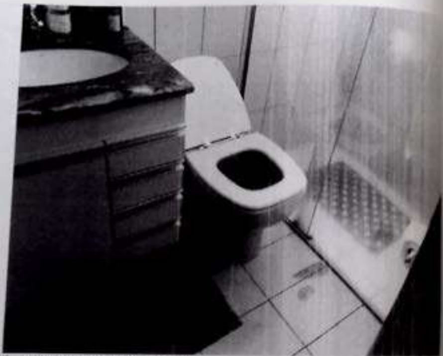
Foto 10: Vista do banheiro social
