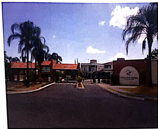
FOTO 01 – PORTARIA DO CONDOMÍNIO
