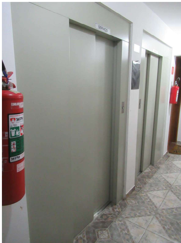
Foto nº. 10 – Vista dos elevadores localizados no pavimento tipo.
