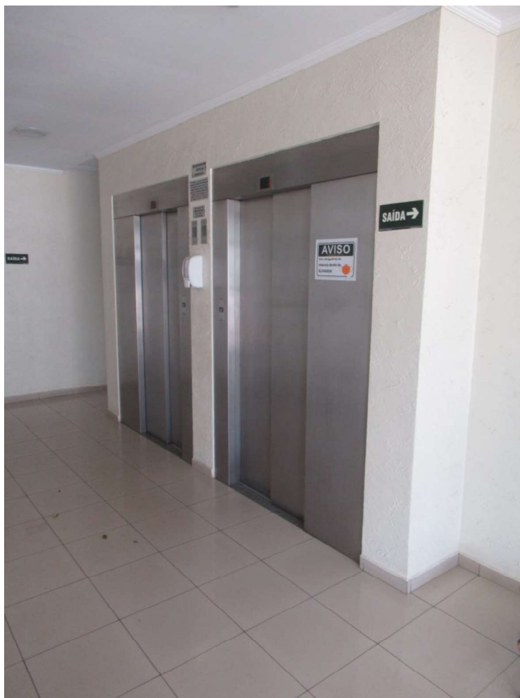
Foto n.º 9 – Vista dos elevadores localizados no hall social.
