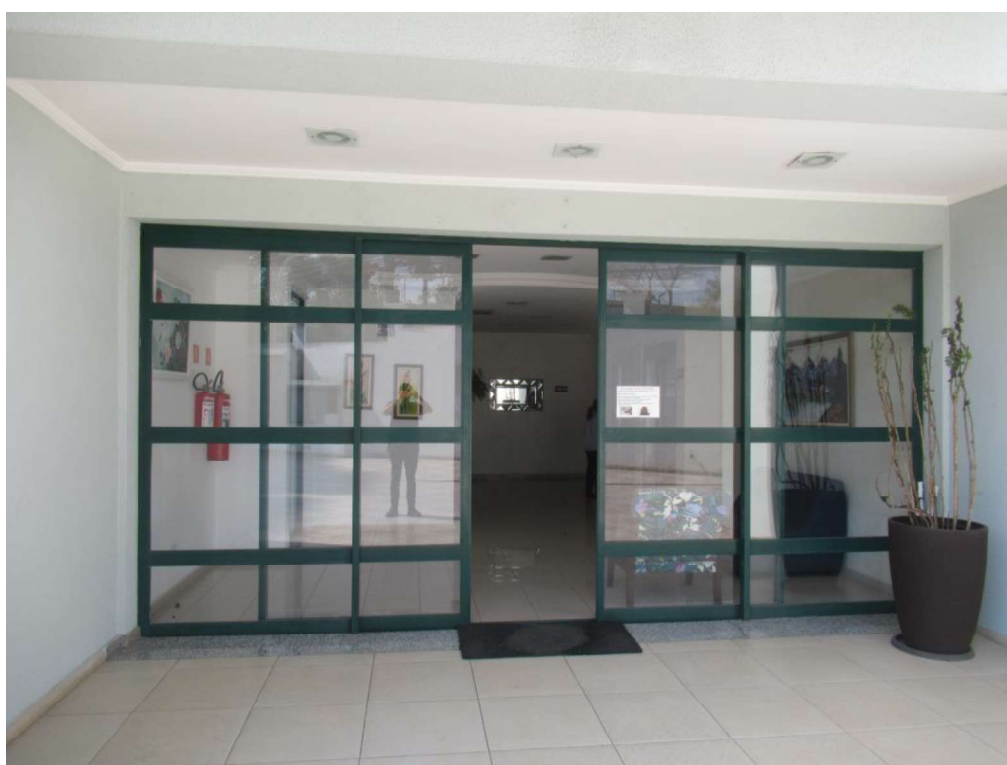
Foto nº. 7 – Vista da entrada do hall social do Bloco 1.
