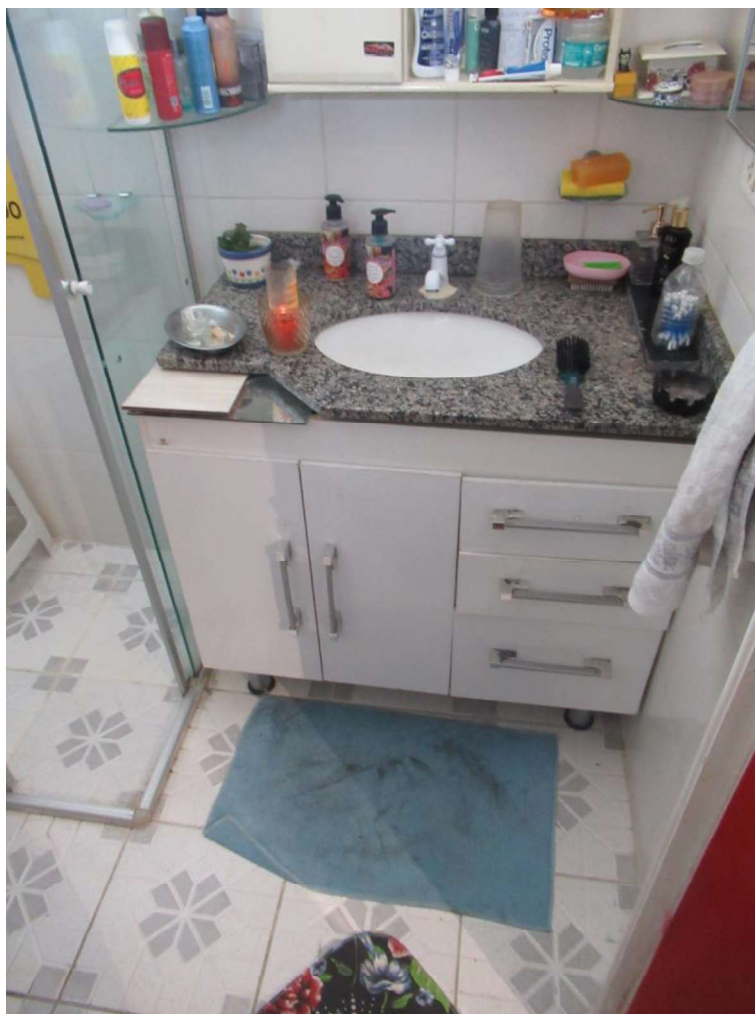
Foto nº. 20 – Vista do banheiro social.
