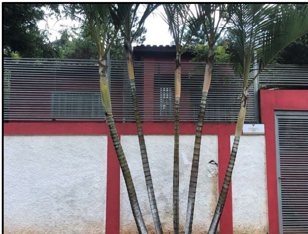
Foto 3: Vista do imóvel
