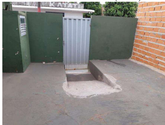
Vista interna da entrada do (1.707)
