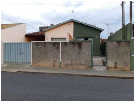
Vista da frente do imóvel
