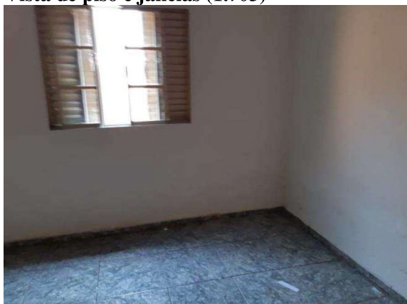
Vista de piso e janelas (1.703)
