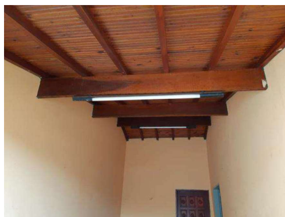
Vista interna da garagem
