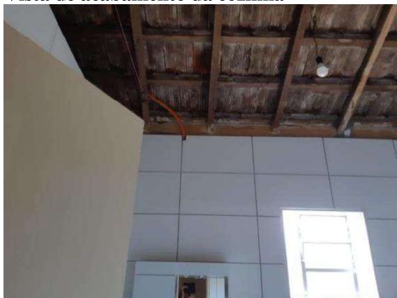
Vista de acabamento da cozinha
