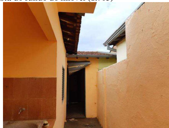
Vista do fundo do imóvel (1.703)
