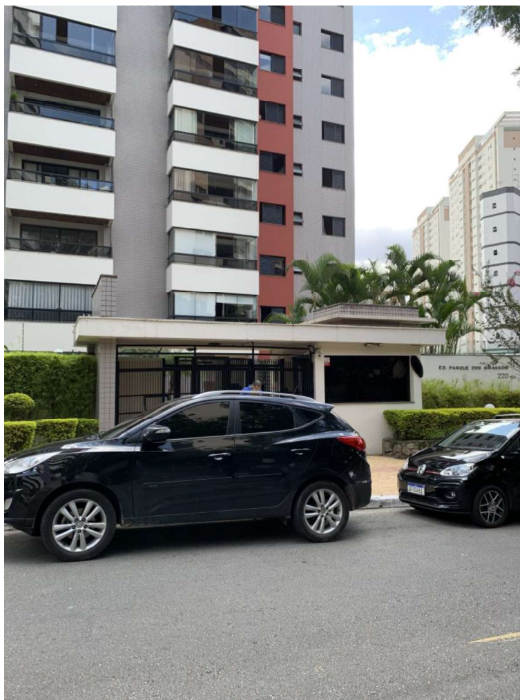
Foto nº. 4 – Vista da portaria do Condomínio Edifício Parque dos Girassóis.
