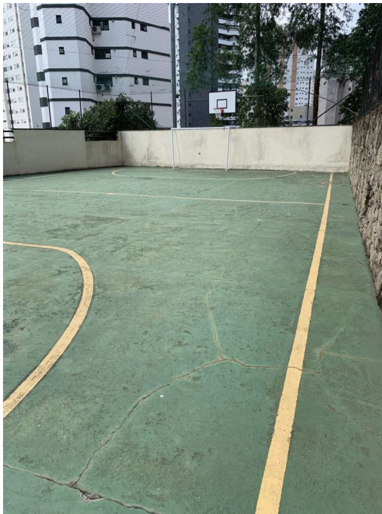
Foto nº. 5 – Vista da quadra poliesportiva.
