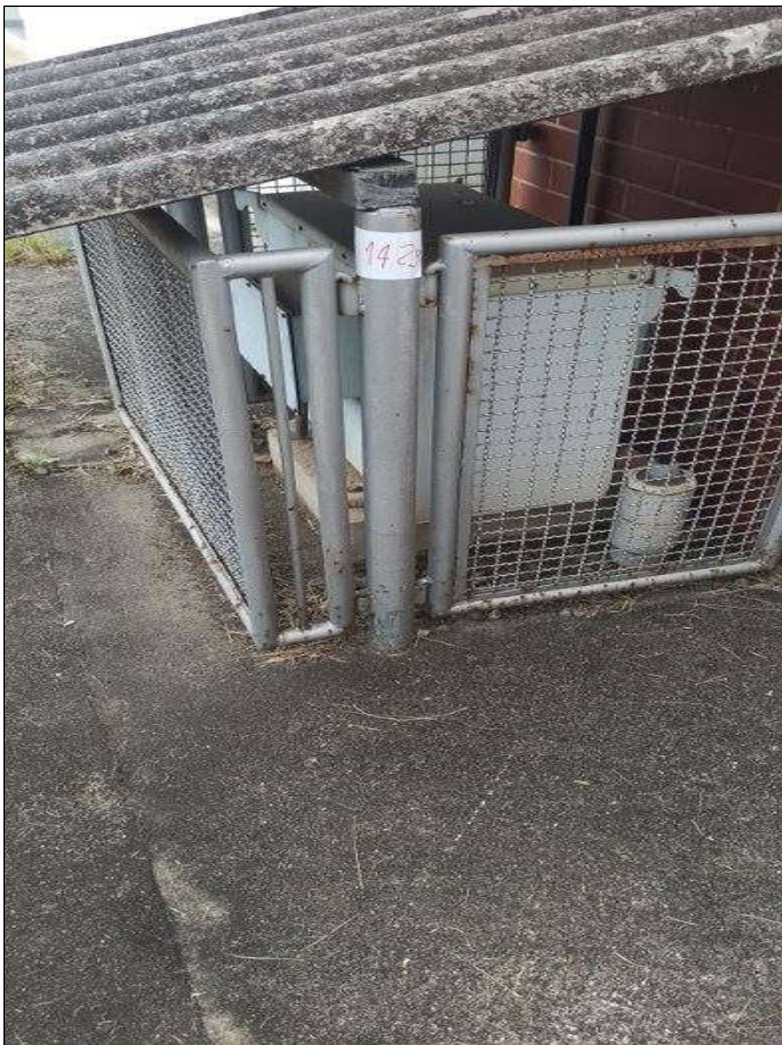
ITEM 1,010 – VISTA DO TRANSFORMADOR, FAB. ULTRASINUS, MOD. 1P55, POT. 15 KVA, ENTR. 480 V, SAIDA 220/127 V, N. SERIE 19430
