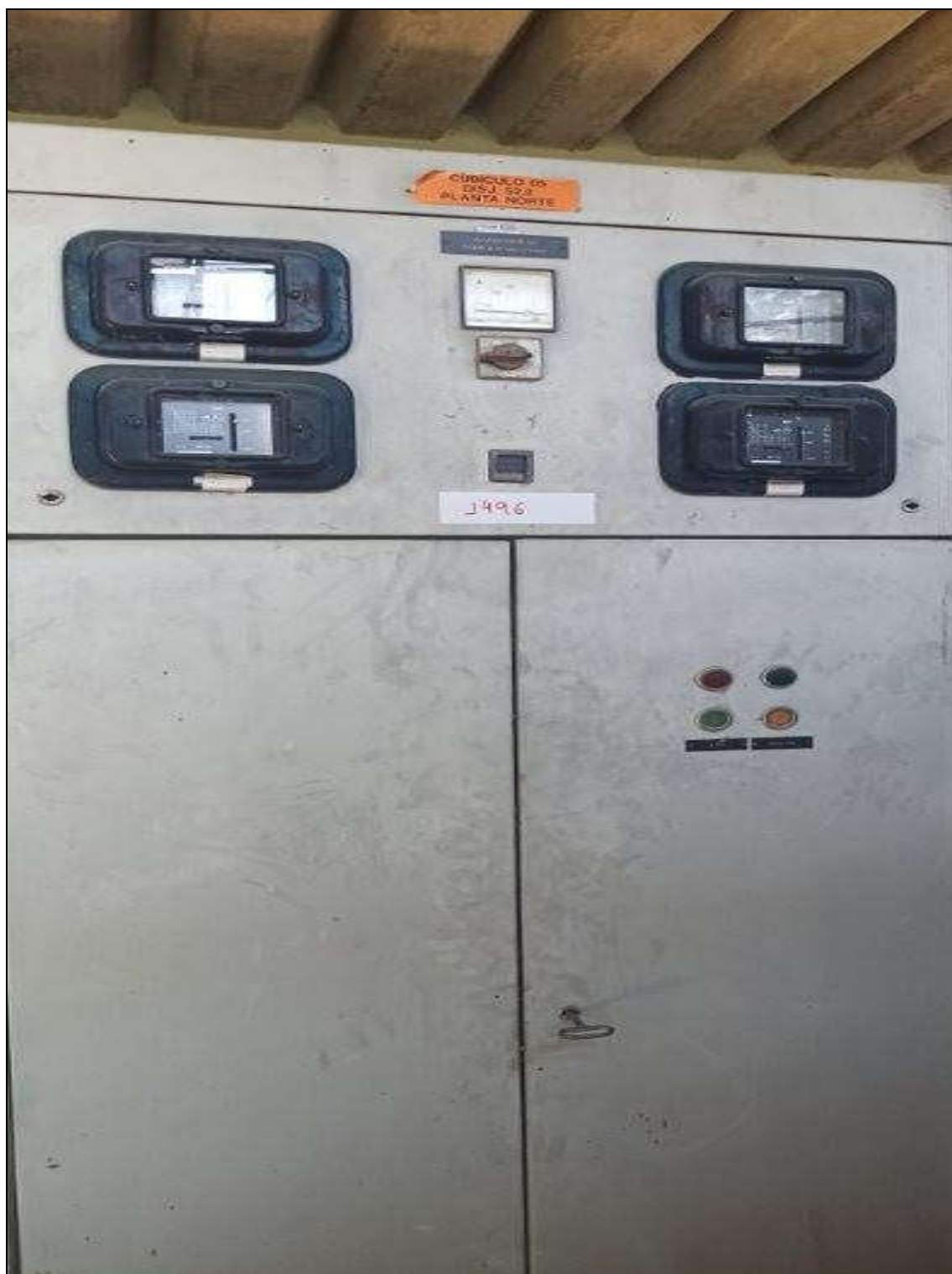
ITEM 1,052 – VISTA DO PAINEL DE ALIMENTACAO E CONTROLE DUPLA FACE 13,8 KV, 04 MODULOS, DIM. 4000X1800X2300 MM
