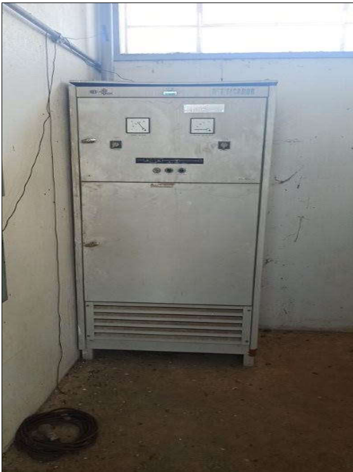
ITEM 1,050 – VISTA DO PAINEL RETIFICADOR, FAB. NIFE, MOD. RI12 5VB0150NM COD 775171606, 22,68 K W, CONJUNTO DE 30 BATERIAS, FAB. LORICA, TIPO 8TM25-2, CAPAC. 200 AH/10H
