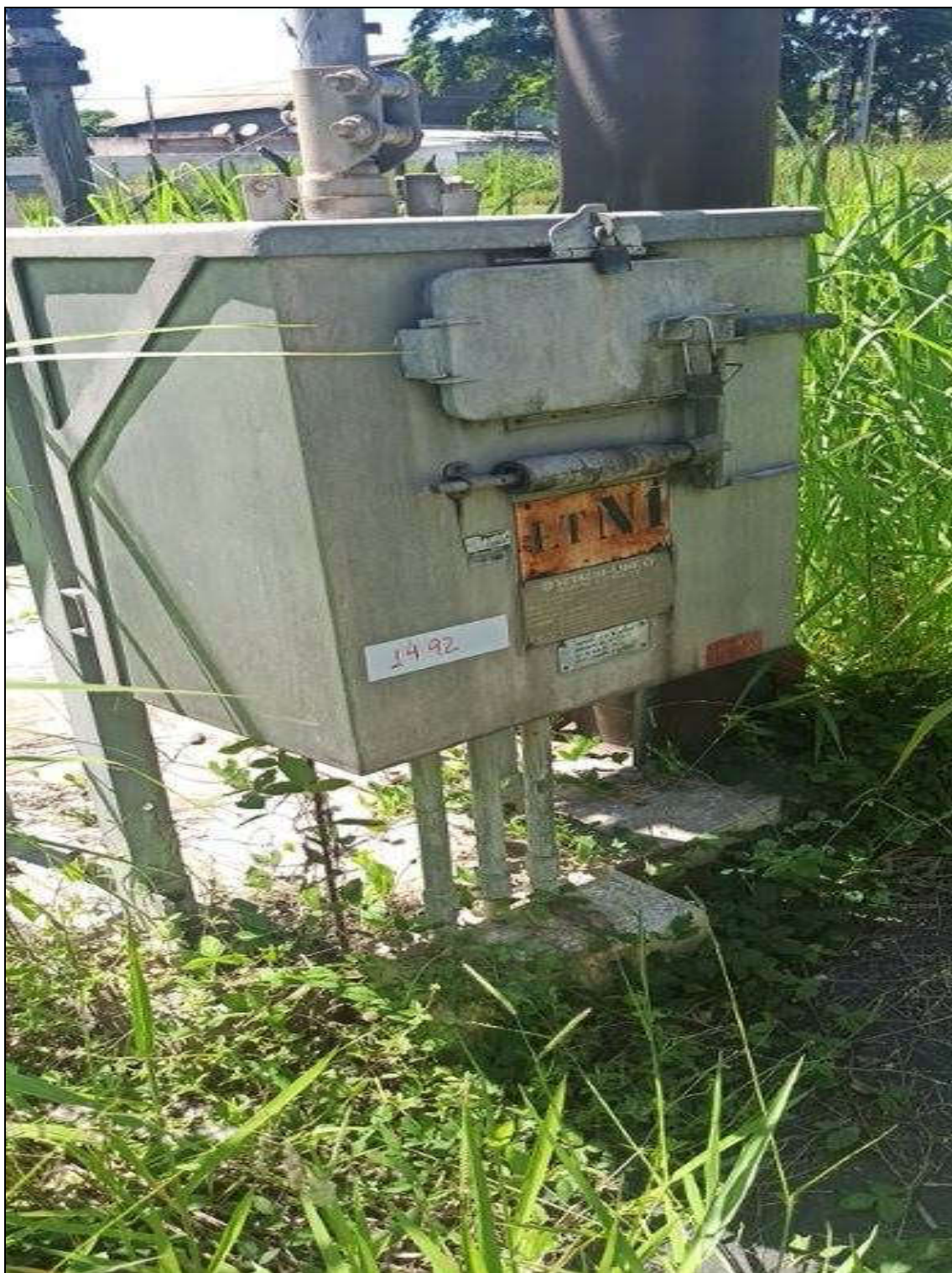
ITEM 1,049 – VISTA DA CHAVE SECCIONADORA MOTORIZADA, FAB. HITACHI, MOD. RB729RB730, MOTOR ELETRICO POT. 0, 5 HP 125 VCC
