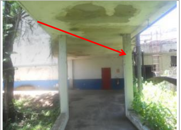
Vista da fachada e acesso
