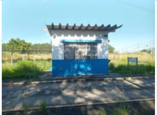
Vista da fachada
