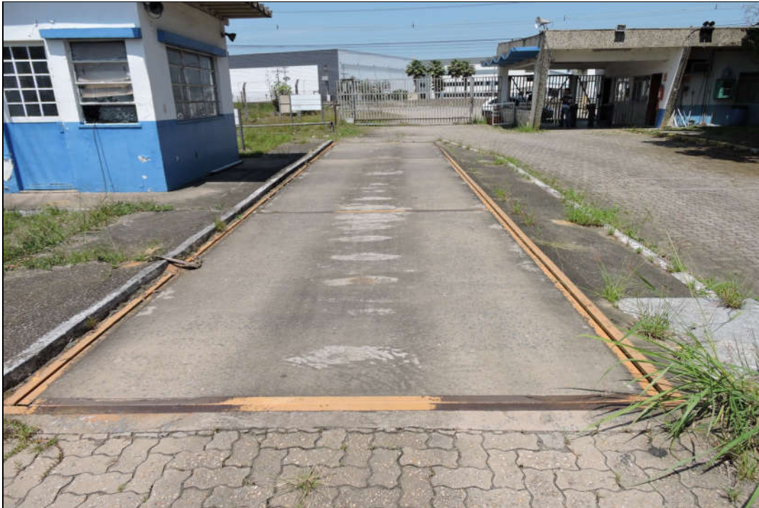
OUTROS - BALANÇA RODOVIARIA - PLATAFORMA
