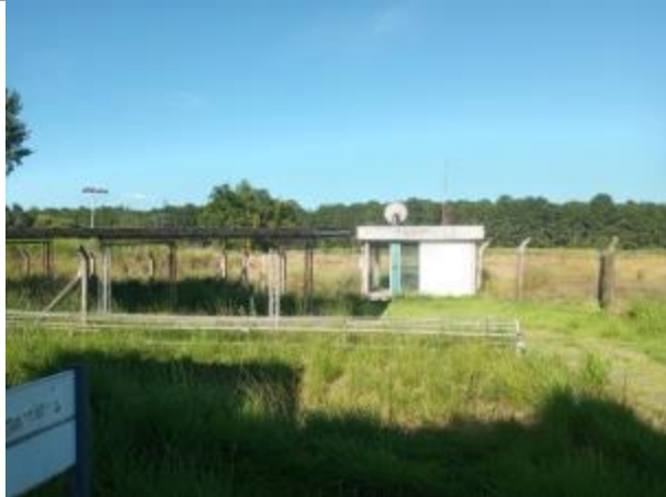
Vista da edificação
