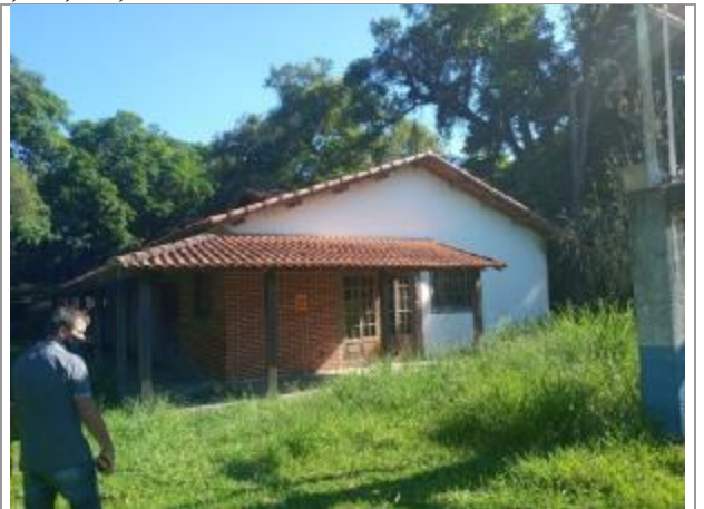
Vista da fachada
