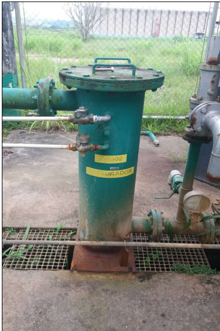
UTILIDADES PLANTA SUL - MISTURADOR ESTÁTICO, MAT. AÇO CARBONO, CAPAC.150 L, DIAM. 300X1100 MM
