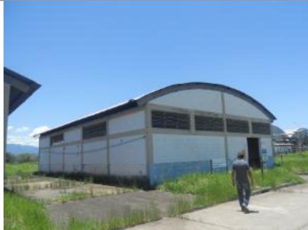
Vista da fachada
